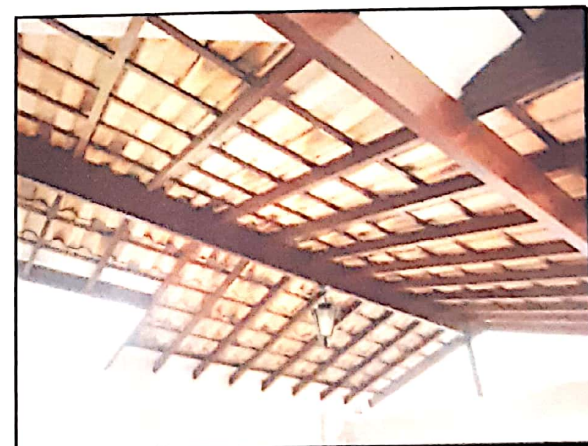
FOTO N.º 10- Tomada da cobertura para abrigo de veículos.
