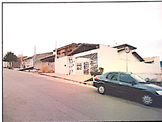
FOTO N.º 08- Tomada lateral do imóvel, com frente a Av. Adelaide Spiandorello Brun.
