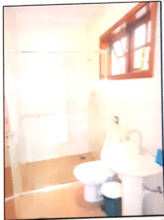
FOTO N.º 26- Tomada interna do banheiro da edícula.
