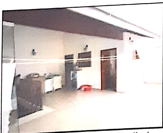
FOTO N.º 21- Vista externa da edícula.
