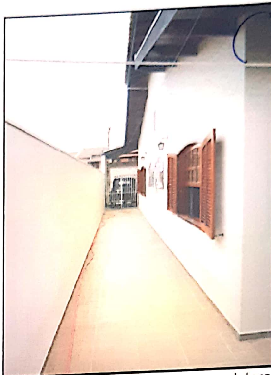
FOTO N.º 20- Aspecto do recuo lateral da edificação.
