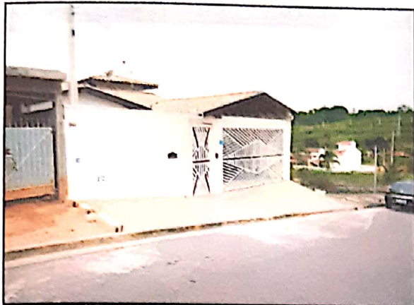
FOTO N.º 05- Vista lateral da fachada do imóvel.
