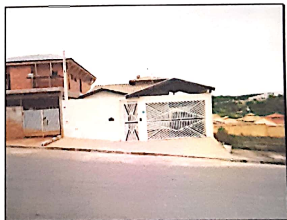
FOTO N.º 04- Aspecto frontal do imóvel.
