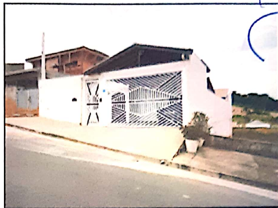
FOTO N.º 06- Tomada lateral da fachada do imóvel.
