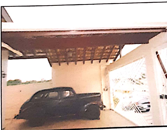
FOTO N.º 09- Detalhe da cobertura para abrigo de veículos.
