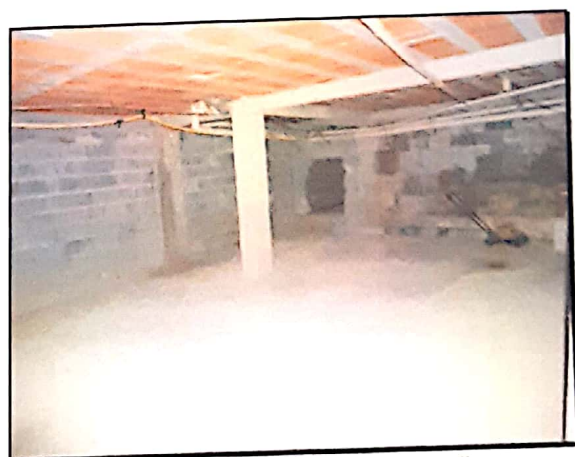
FOTO N.º 30- Vista do porão, sem acabamento.
