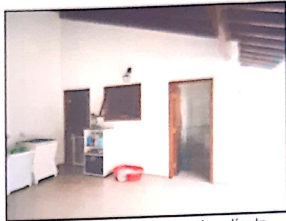
FOTO N.º 24- Vista externa da edícula.
