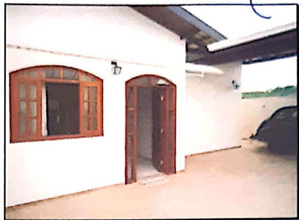
FOTO N.º 12- Tomada externa da residência.
