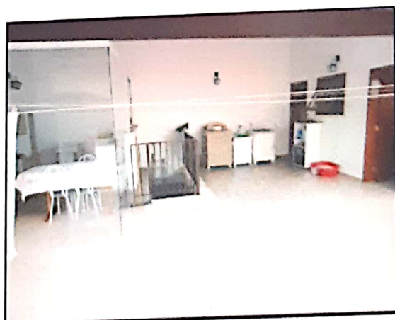
FOTO N.º 22- Aspecto da cobertura.
