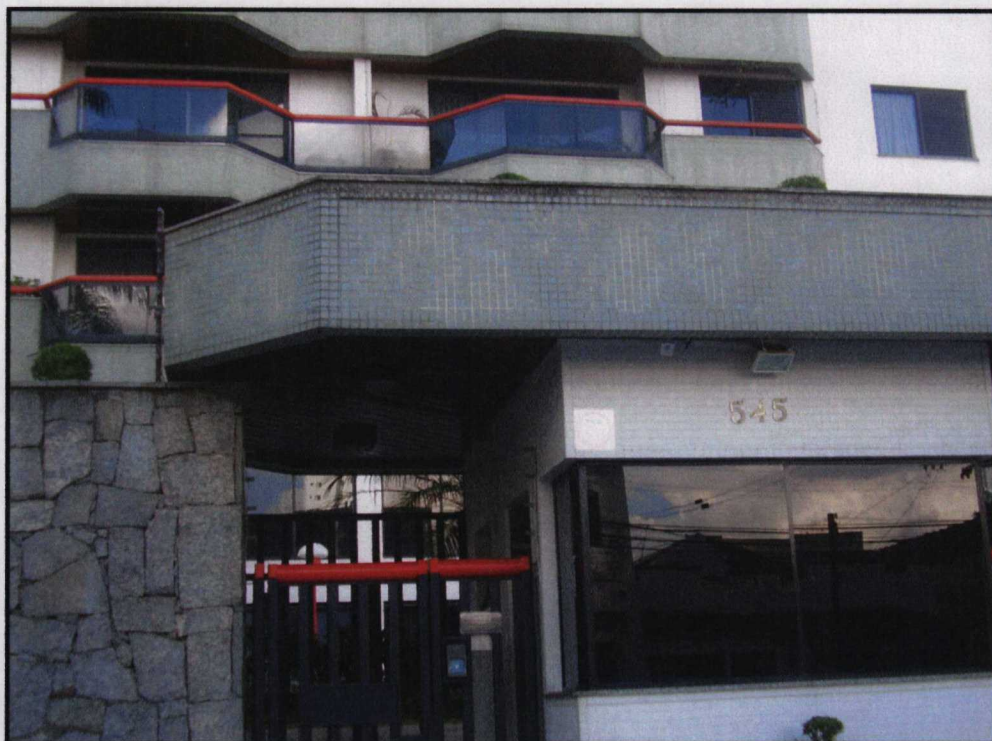
Foto nº01: A portaria do Condomínio Edifício Blumenau, onde se localiza o imóvel em análise.
