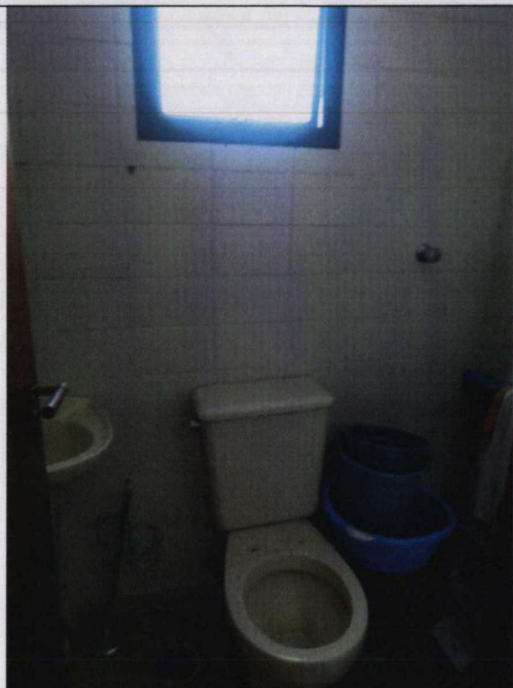
Foto nº35: Vista parcial do banheiro 2, da dependência de empregada
