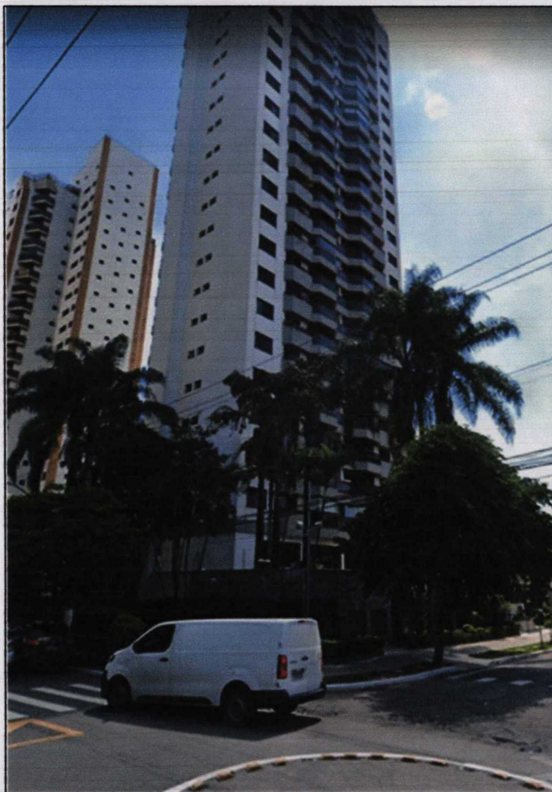
Foto nº01 : Vista da fachada do 'Edifício Blumenau', à Rua Aguapei nº545
