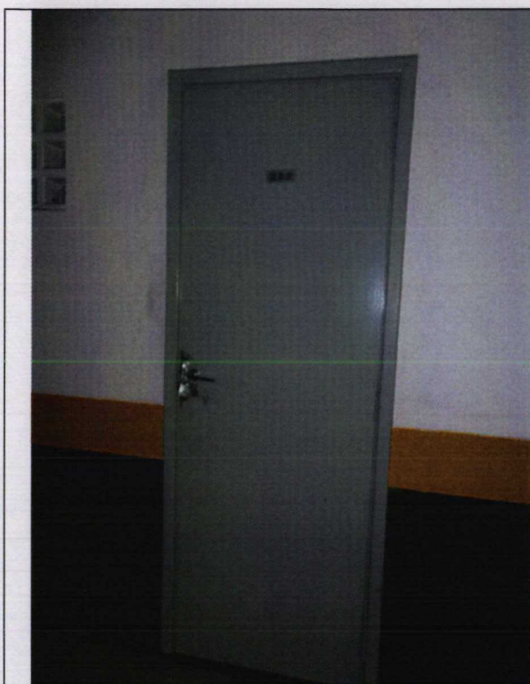
Foto nº51: Vista parcial do depósito, localizado no estacionamento, próximo às vagas de carro do apartamento
