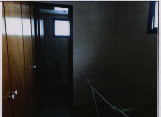
Foto nº34: Vista parcial da dependência de empregada
