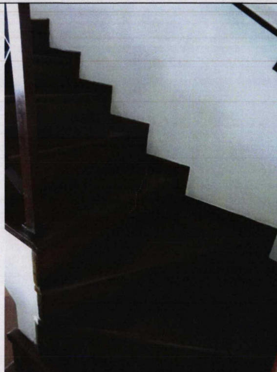
Foto nº36: Vista parcial da escada, revestida de madeira, para acesso ao segundo pavimento do apartamento
