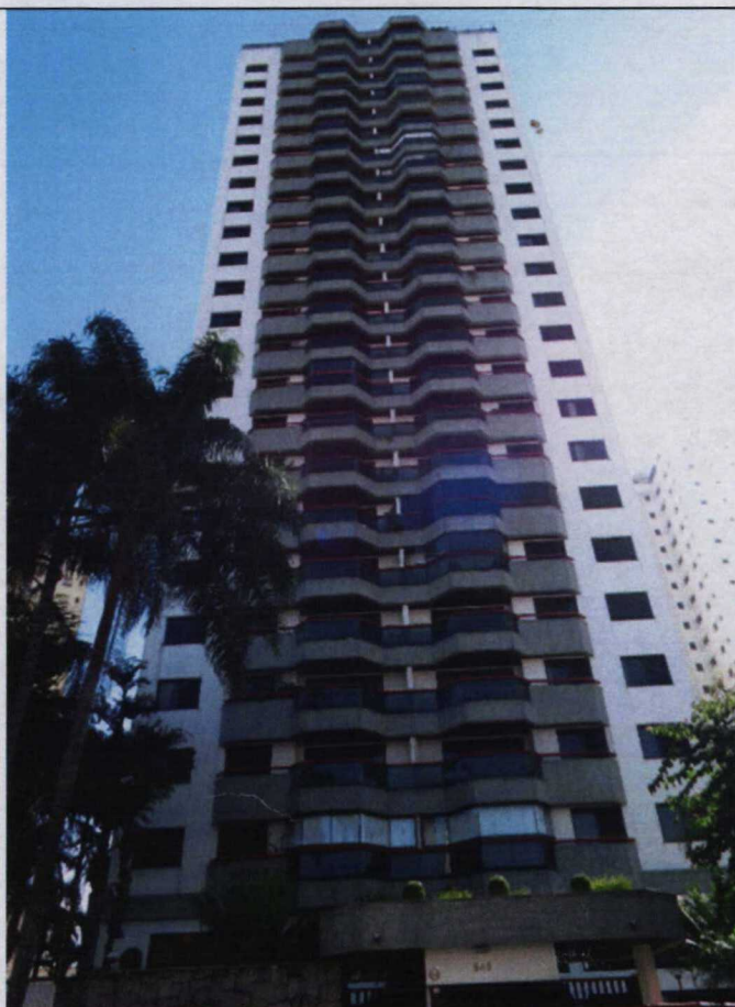
Foto n°01: Vista da fachada do 'Condomínio Edifício Blumenau'
