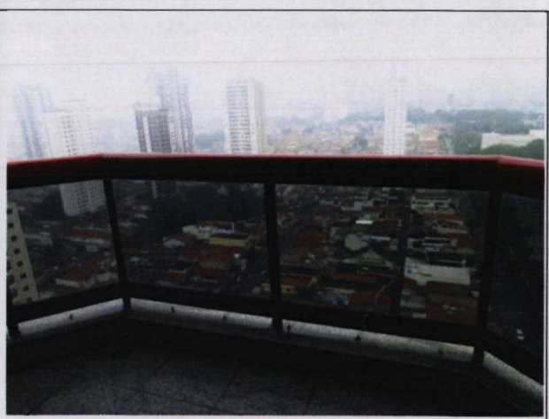
Foto nº38: Vista parcial da sacada da sala de estar 2
