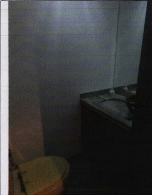
Foto nº23: Vista parcial do lavabo
