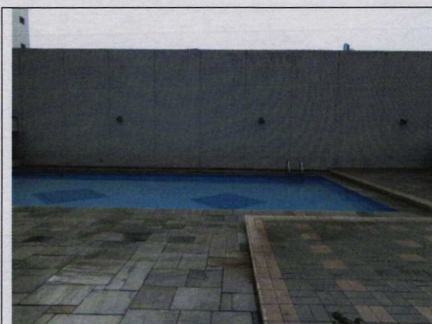
Foto nº13: Vista parcial da piscina
