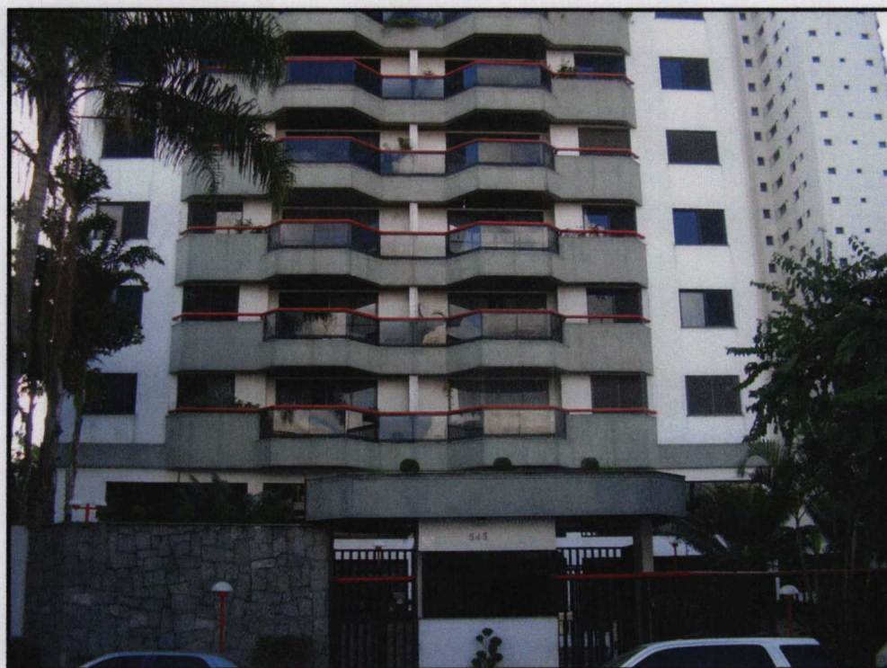
Foto nº02: A fachada principal do edifício onde se encontra o apartamento penhorado.
