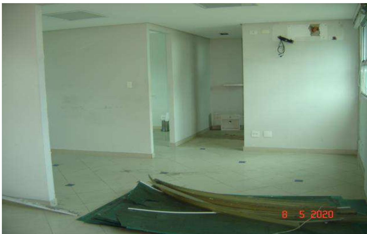
28 – Padrão de salas internas, com divisórias Dry-Wall
