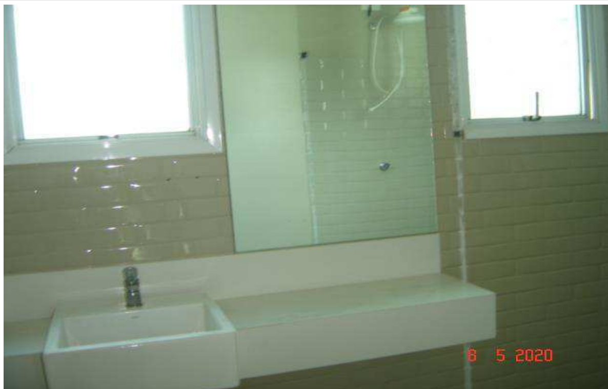
21 – Terceiro andar. Banheiro.
