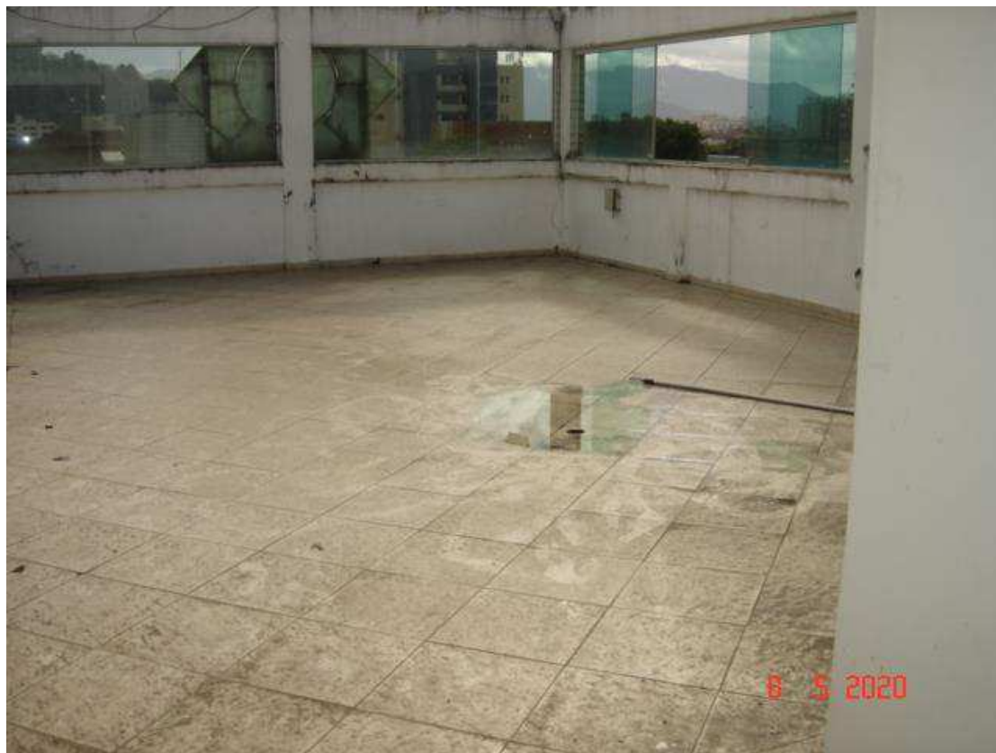
22 – Quarto andar. Área descoberta, para recreação.
