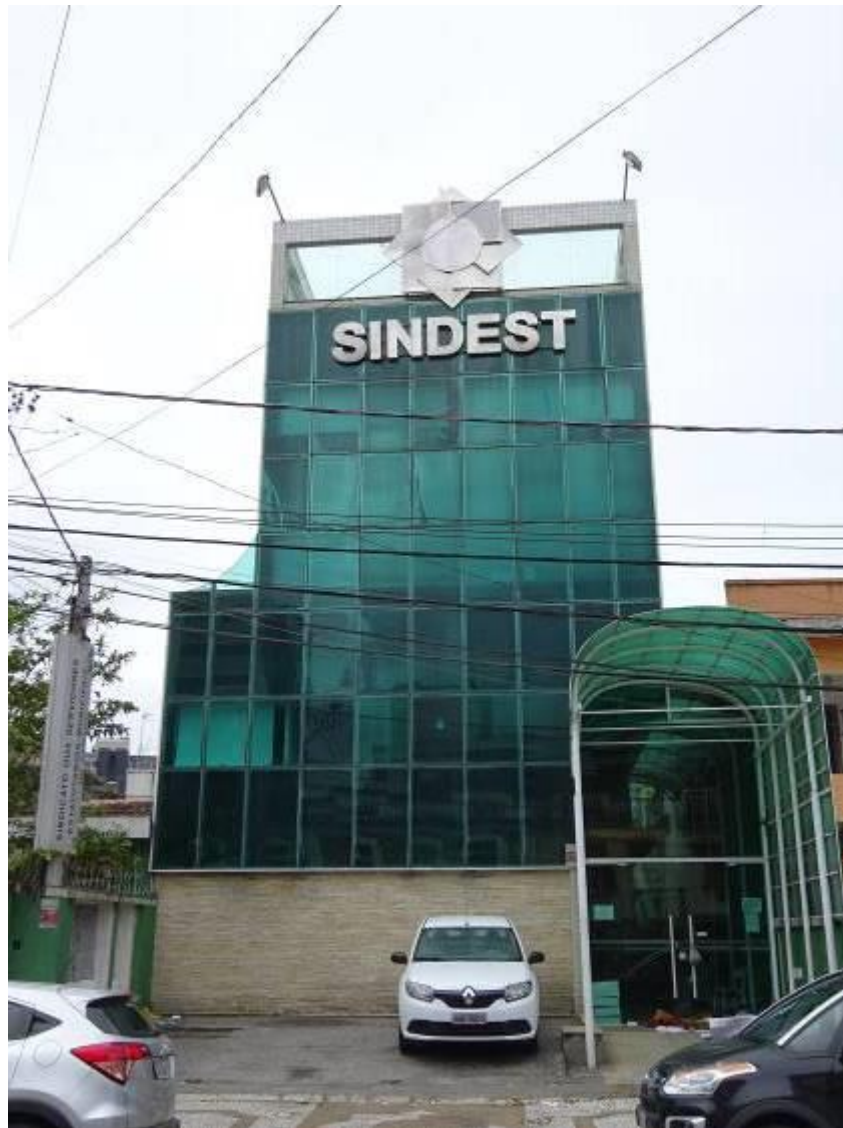
FOTO 01: Vista Geral da fachada frontal do Imóvel.
