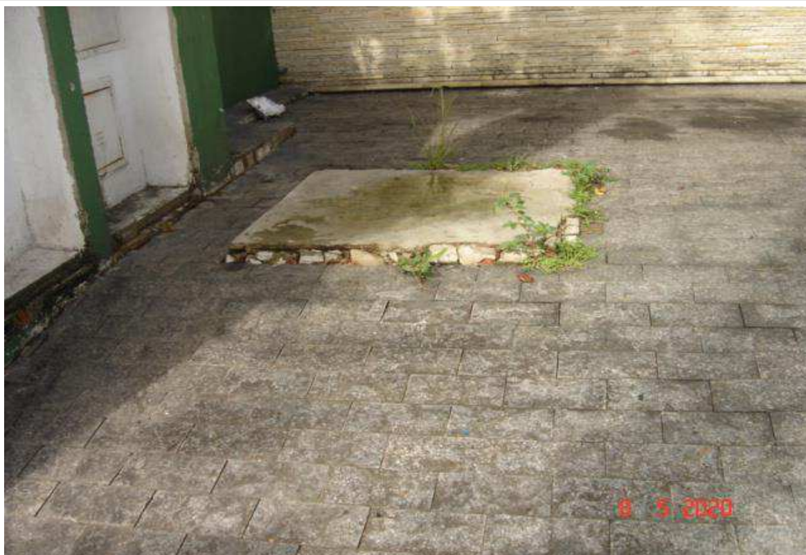
25 – Tampa da Caixa d’água, no pavimento térreo, à frente da edificação.
