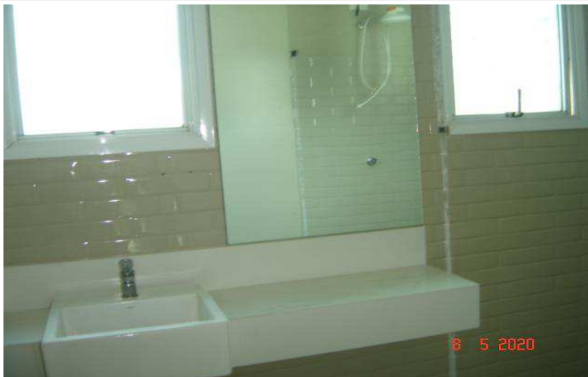
21 – Terceiro andar. Banheiro.
