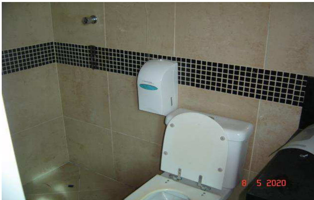
16 – Segundo andar. Banheiro.
