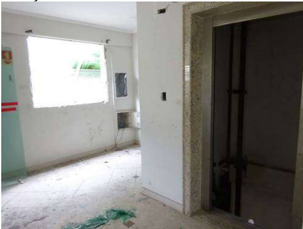
FOTO 06: Pavimento Mezanino: Vista de hall de distribuição.
