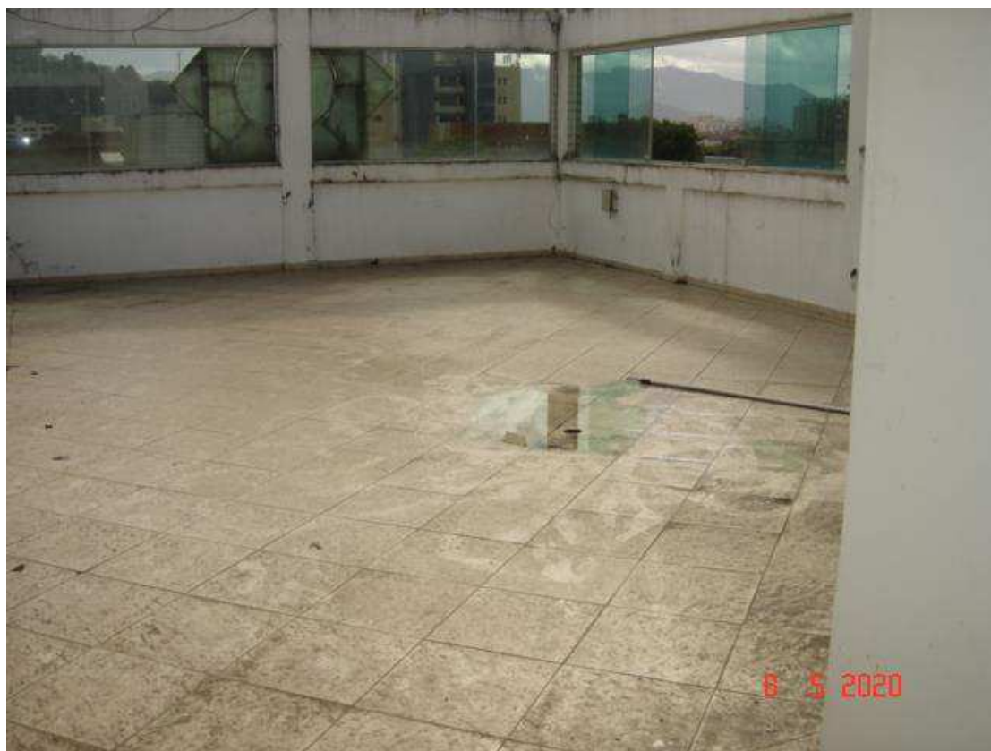
22 – Quarto andar. Área descoberta, para recreação.
