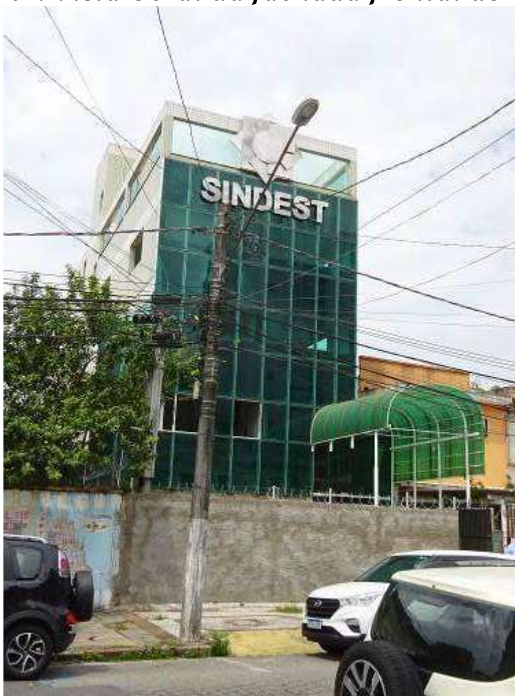
FOTO 01: Vista Geral da fachada frontal do Imóvel.
