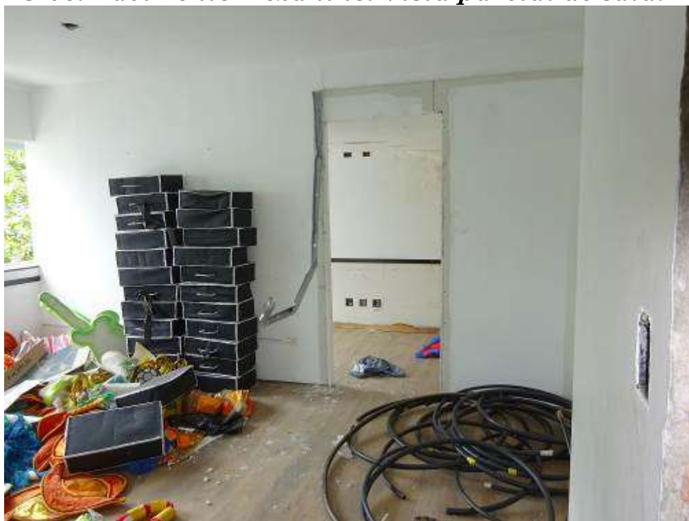
FOTO 08: Pavimento Mezanino: Vista parcial de sala.
