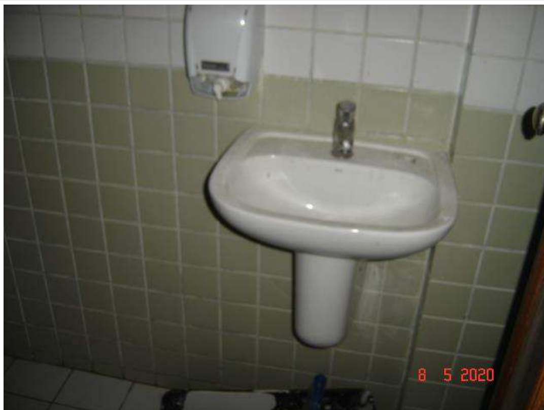
7 – Banheiro, pavimento térreo
