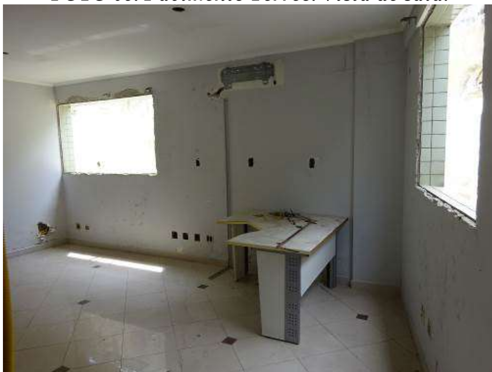
FOTO 05: Pavimento Térreo: Vista de sala.
