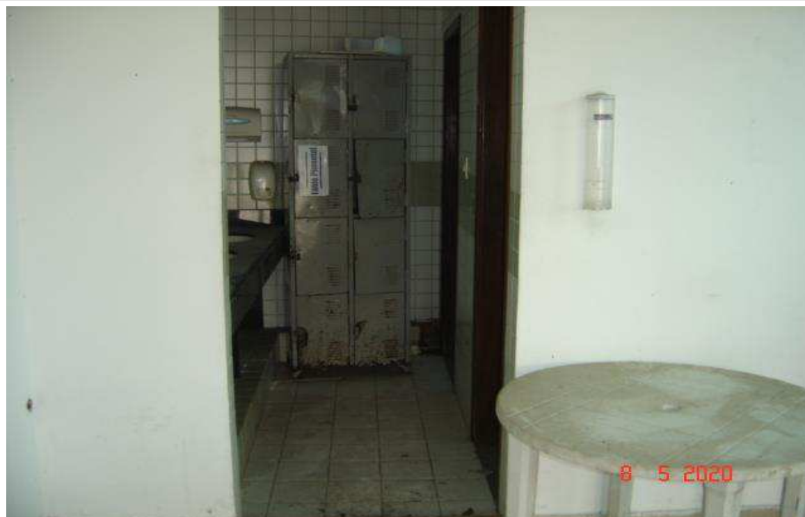
23 – Quarto andar. Área coberta, para recreação. Armários e acesso a sanitários.
