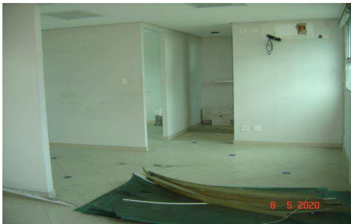
28 – Padrão de salas internas, com divisórias Dry-Wall
