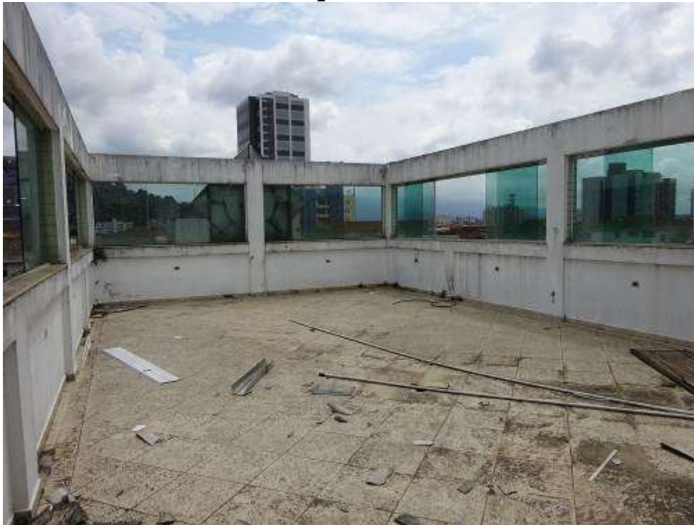
FOTO 14: Cobertura: Vista parcial de área descoberta.
