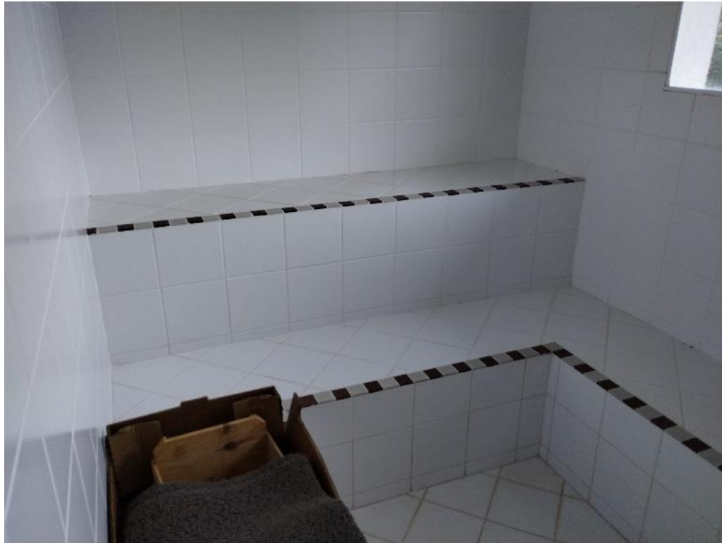
FOTO Nº 23 – ÁREA DE LAZER, SAUNA
