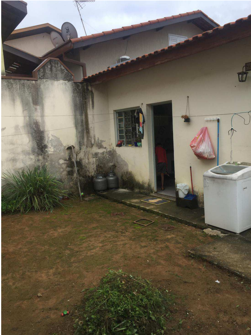
Fig. 10 Foto dos fundos do imóvel avaliando.
