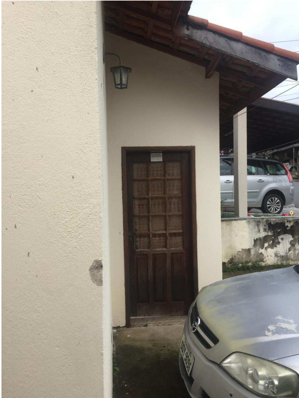
Fig. 6 Foto da porta de entrada principal do imóvel avaliando.
