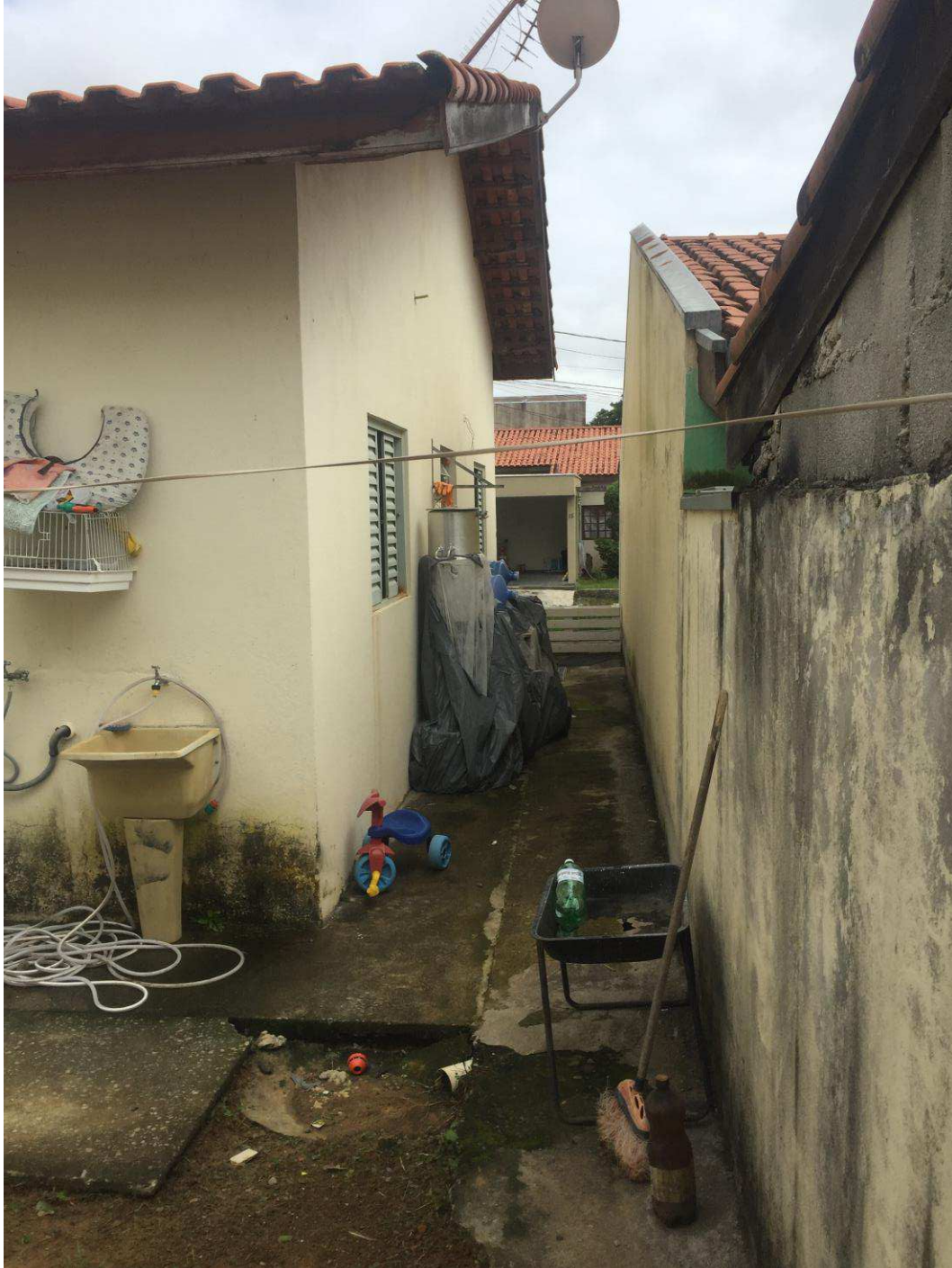
Fig. 9 Foto do corredor lateral externo da casa.
