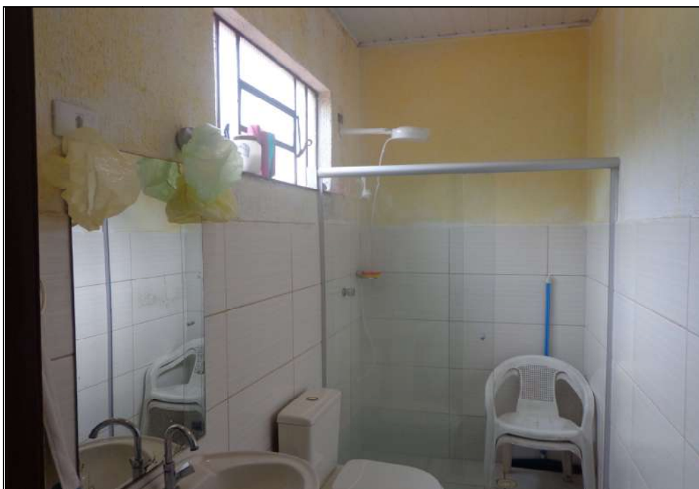
Foto 13 – Vista interna do imóvel (n.º 167 – Casa 2).
