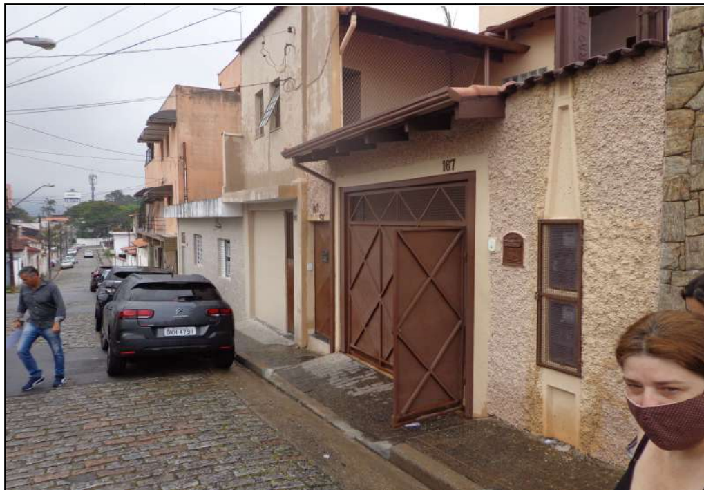
Foto 02 – Vista lateral direita (LD) com logradouro.
