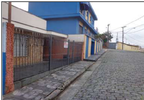
Foto 36 – Vista LE com logradouro
