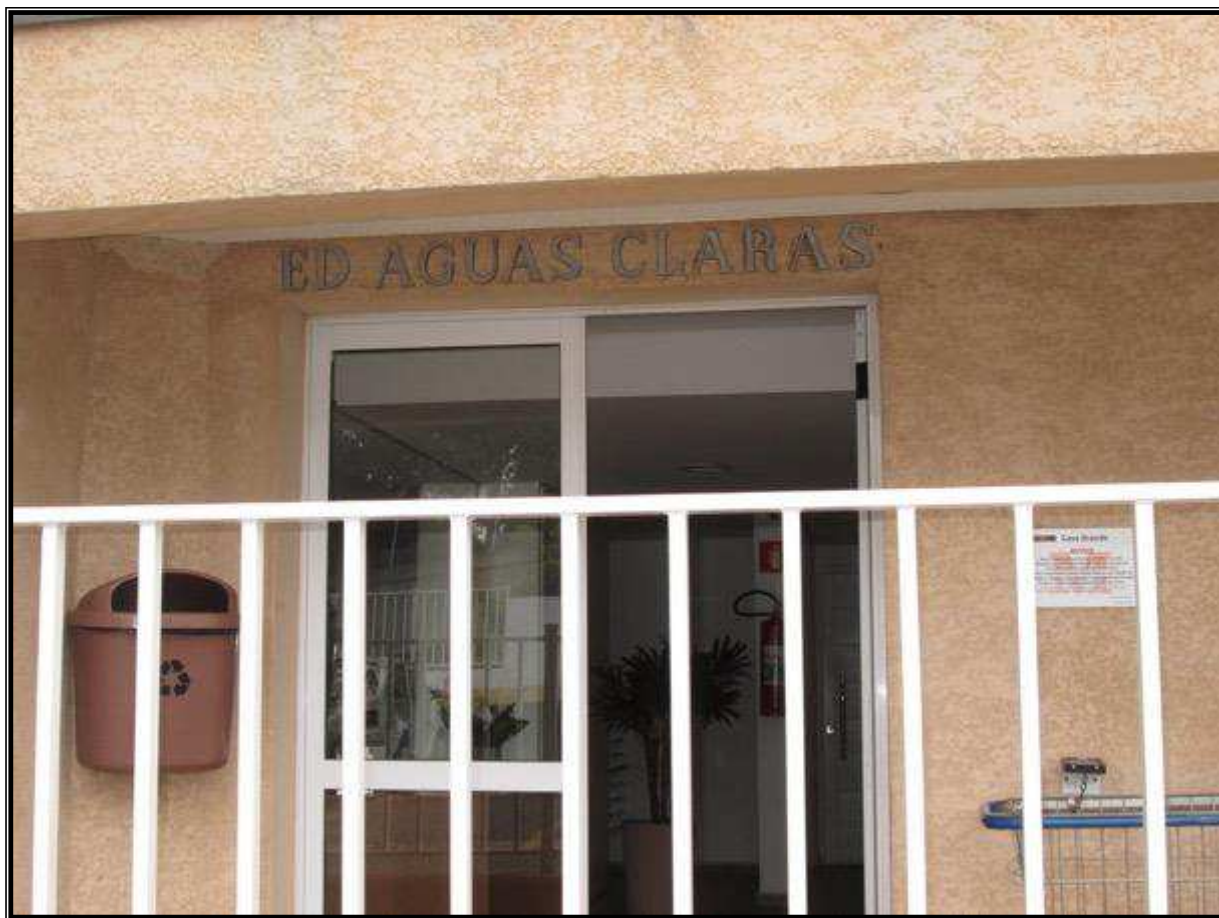
Entrada do Edifício Águas Claras, onde se localiza o imóvel (ap. 21).
