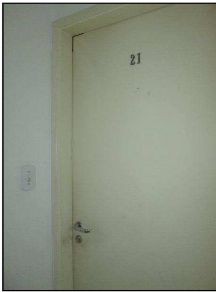
Porta de acesso ao apartamento 21.
