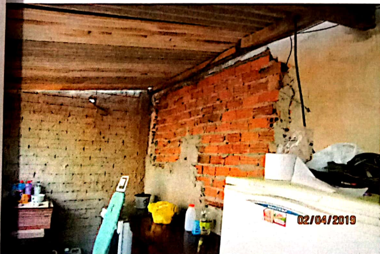
FOTO N° 12 Vista localizada do anexo coberto externo
