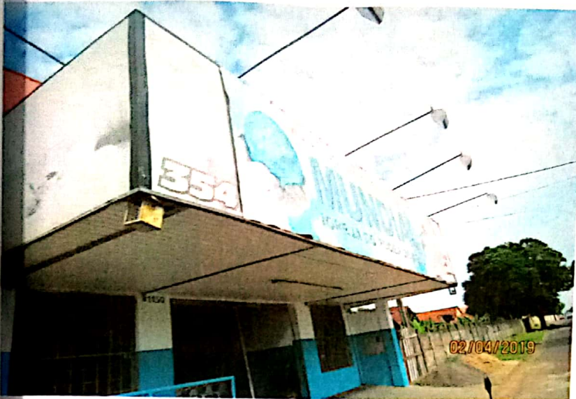
FOTO N° 4 Marquise, vista reversa
