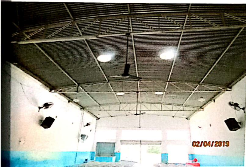
FOTO N° 5 Vista interna do salão principal - estrutura metálica de cobertura, iluminação, ventilação
