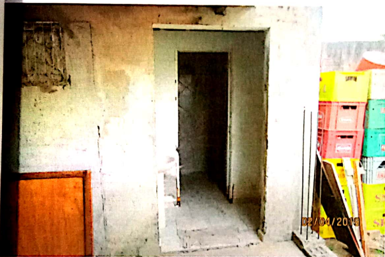
FOTO N° 11 Sanitário externo - aspecto geral
