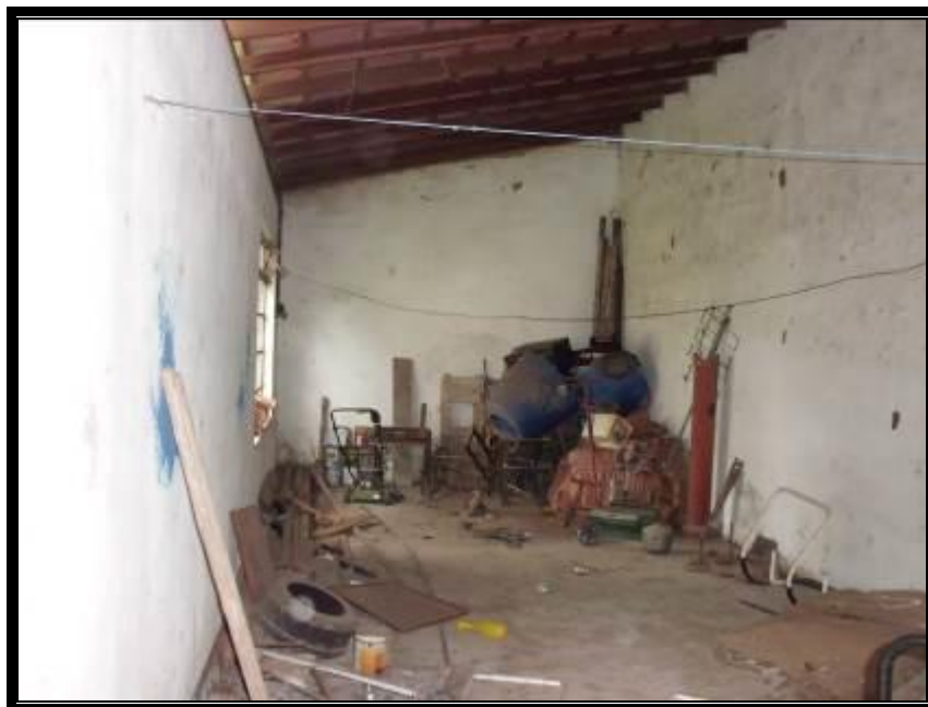
Edificação de apoio: Vista interna.
