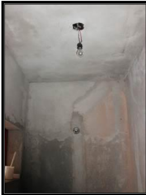
Edificação residencial – térreo: Lavabo.
