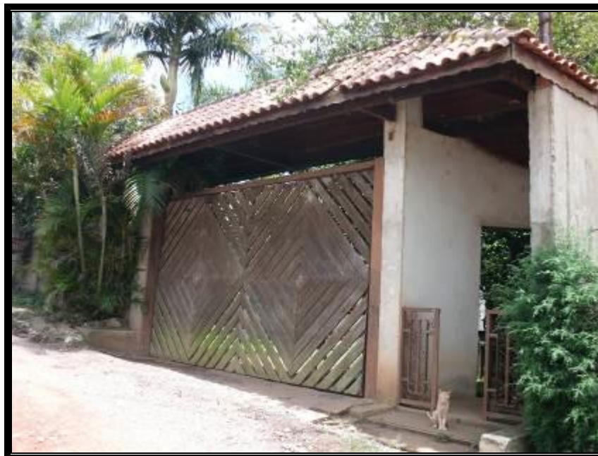
Vista da frente do imóvel avaliando.
