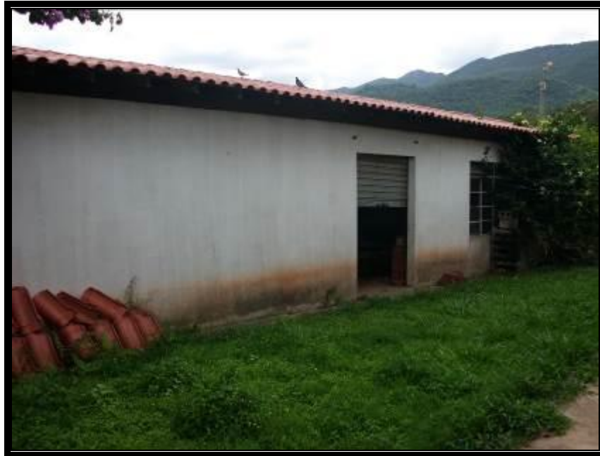
Edificação de apoio: Vista externa.
