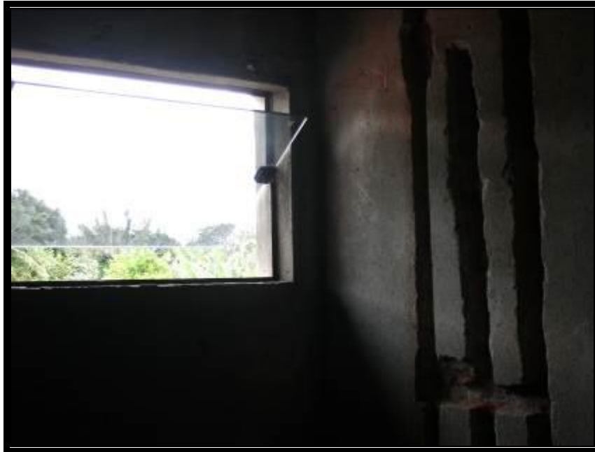
Edificação residencial – superior: Banheiro da suíte.
