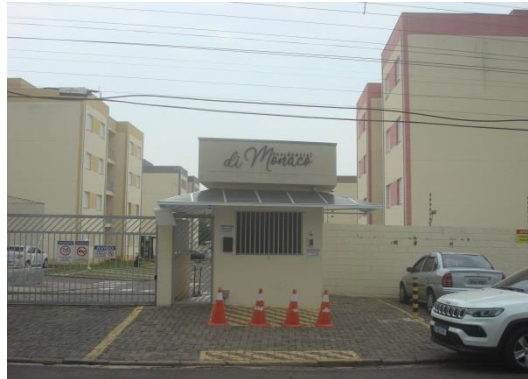
Vistas da fachada do Condomínio
