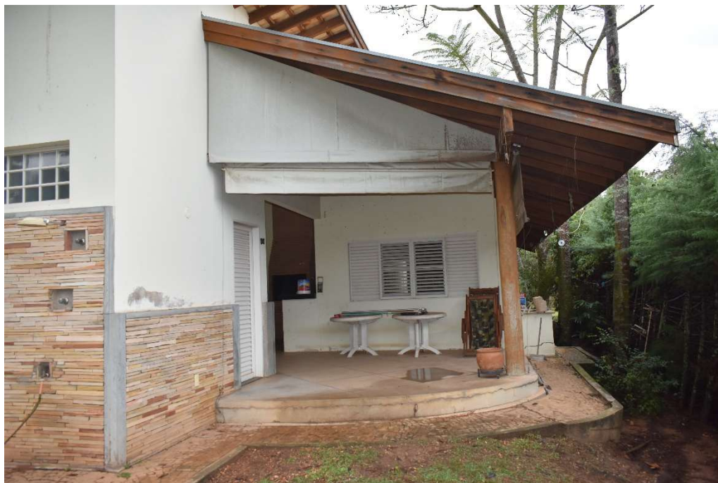
Foto 03 – Vista da janela do quarto e do banheiro masculino. Pequena varanda ao lado da cozinha.
