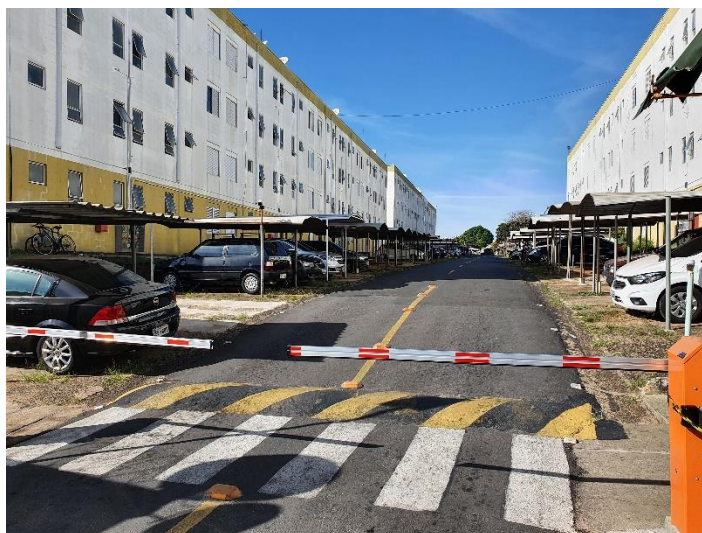
Acesso de veículos
