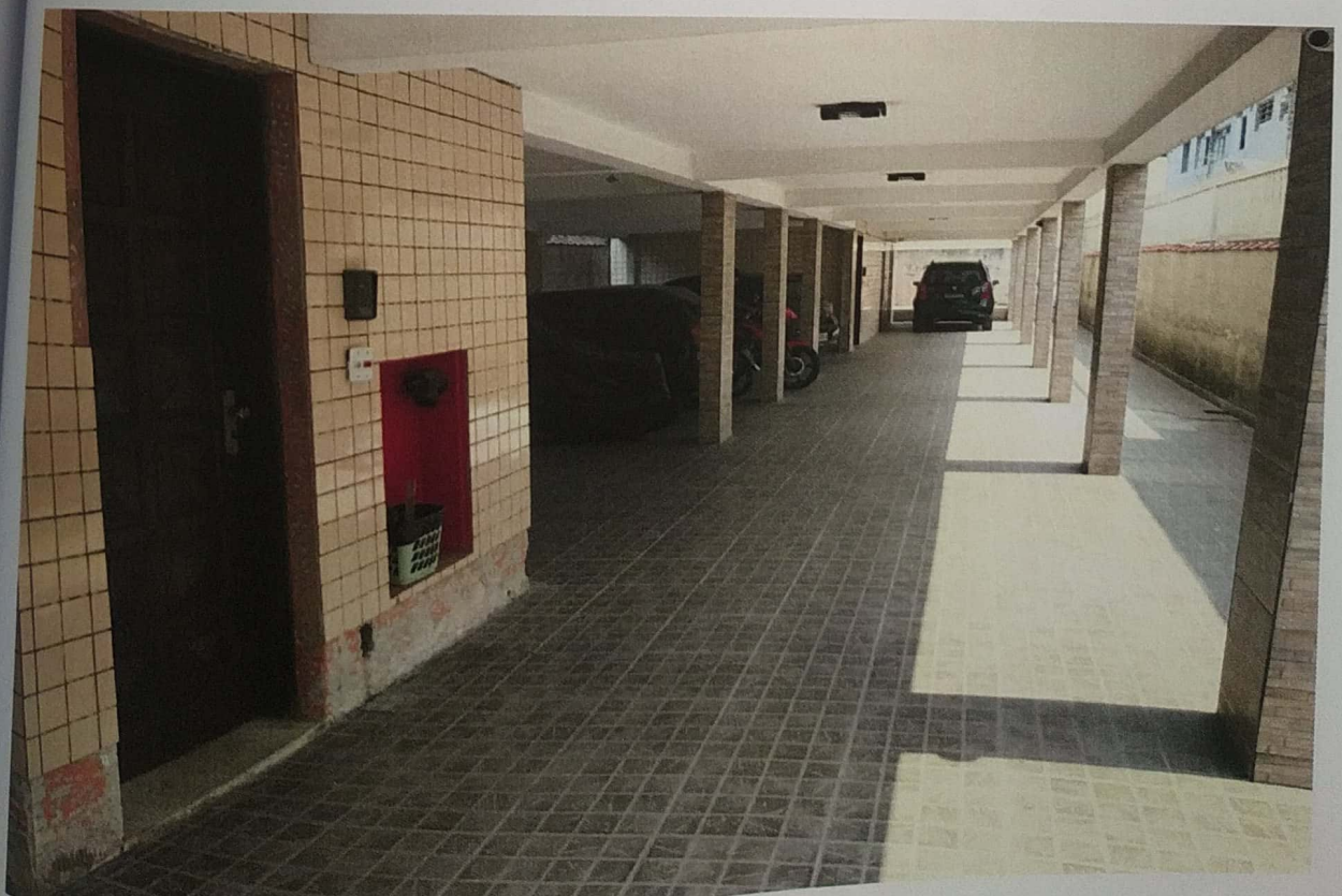
FOTO 04 - Vista parcial externa do pavimento térreo do imóvel avaliando (garagens).
