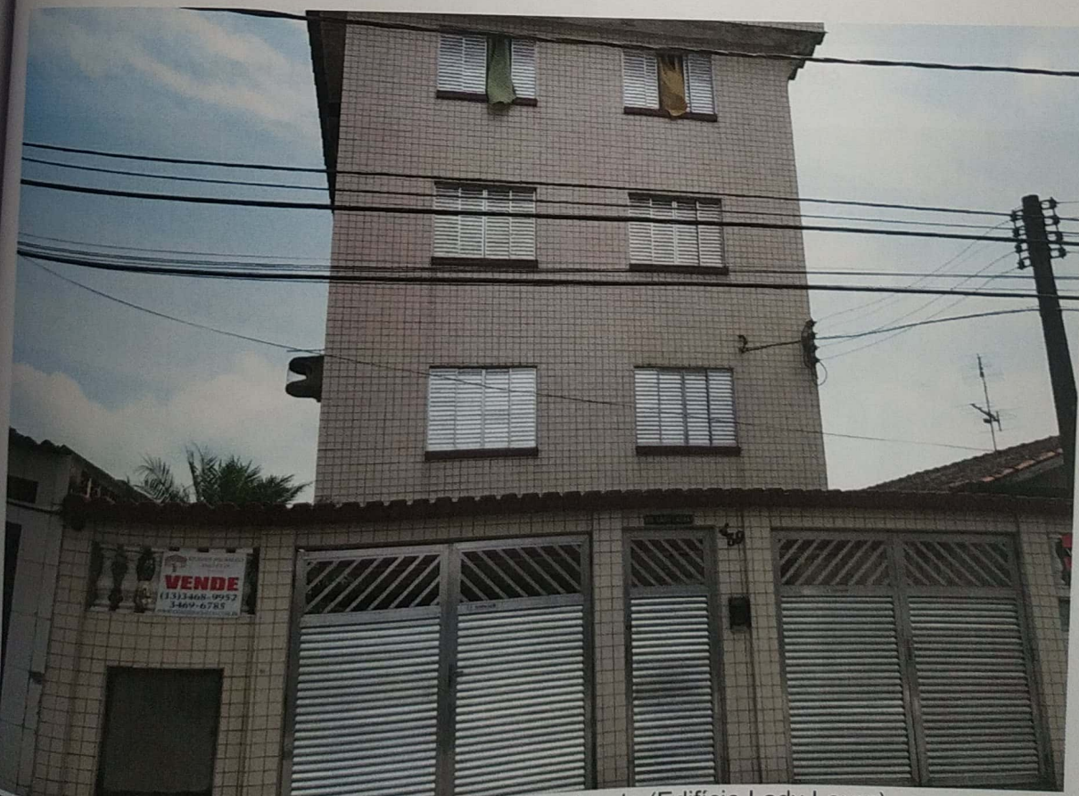
FOTO 02 – Vista parcial da Fachada do imóvel avaliando (Edifício Lady Laura).
