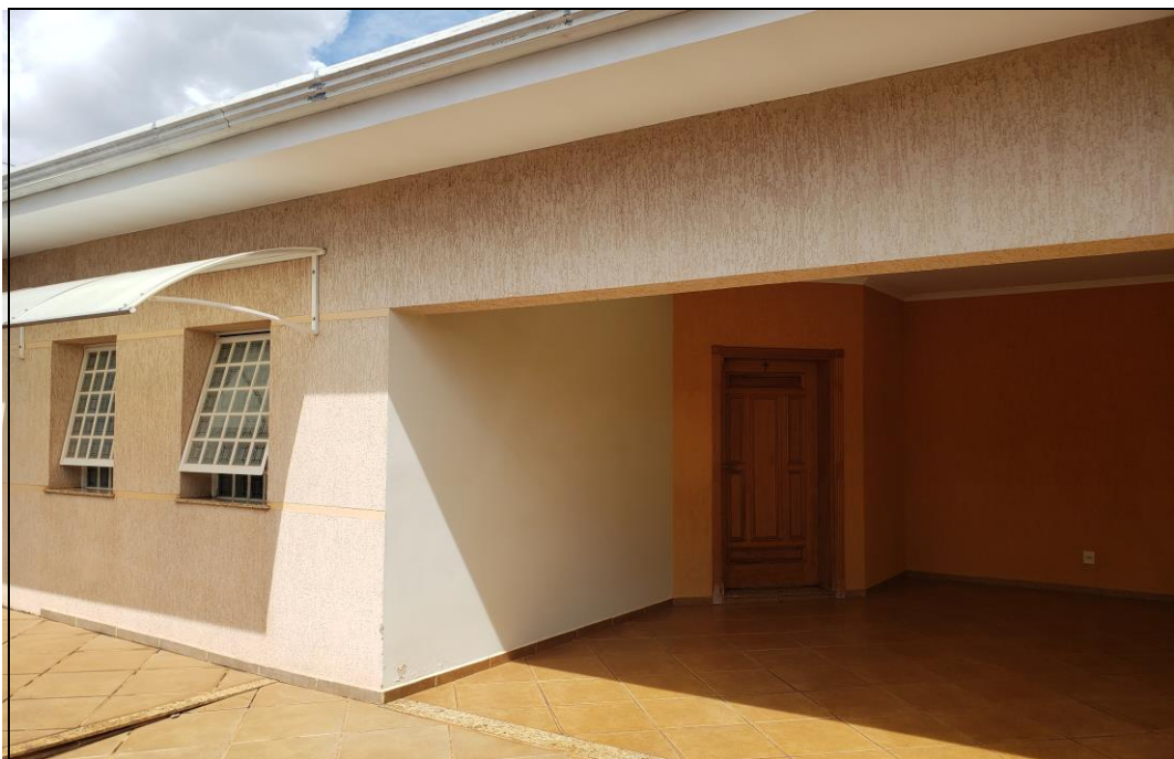
FOTO 02 – vista frontal da edificação.
