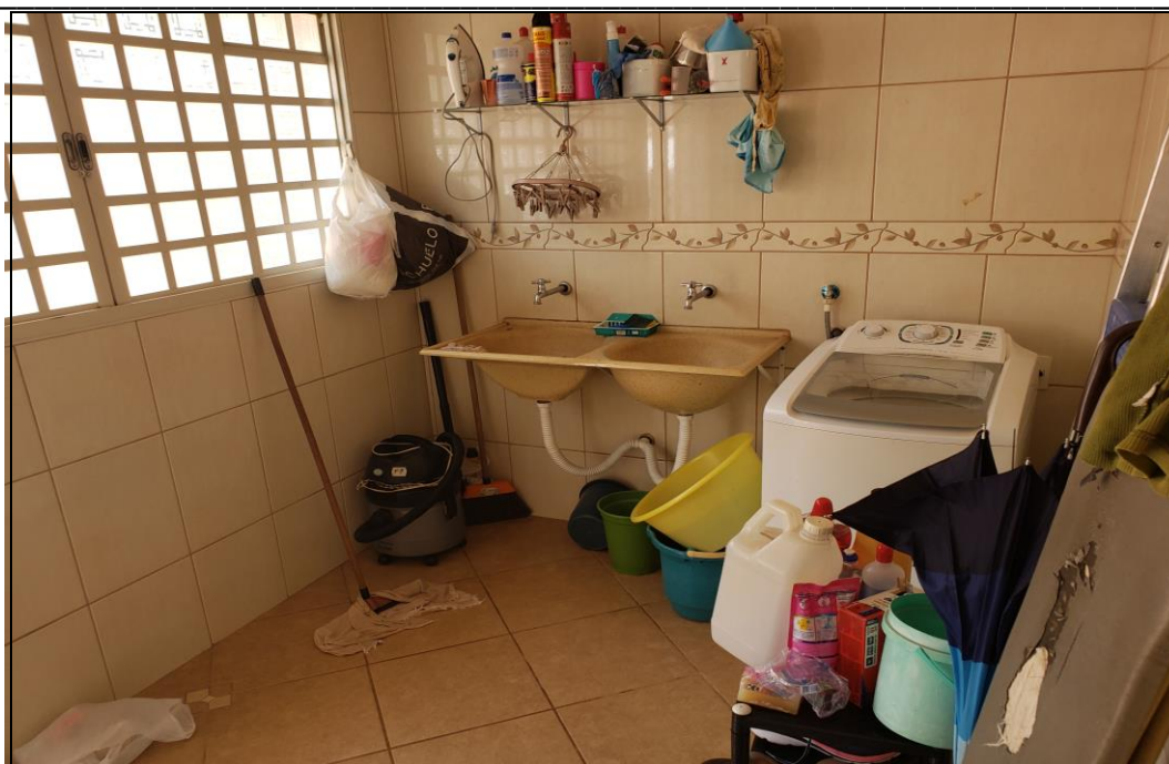
FOTO 13 – vista geral da lavanderia do imóvel.
