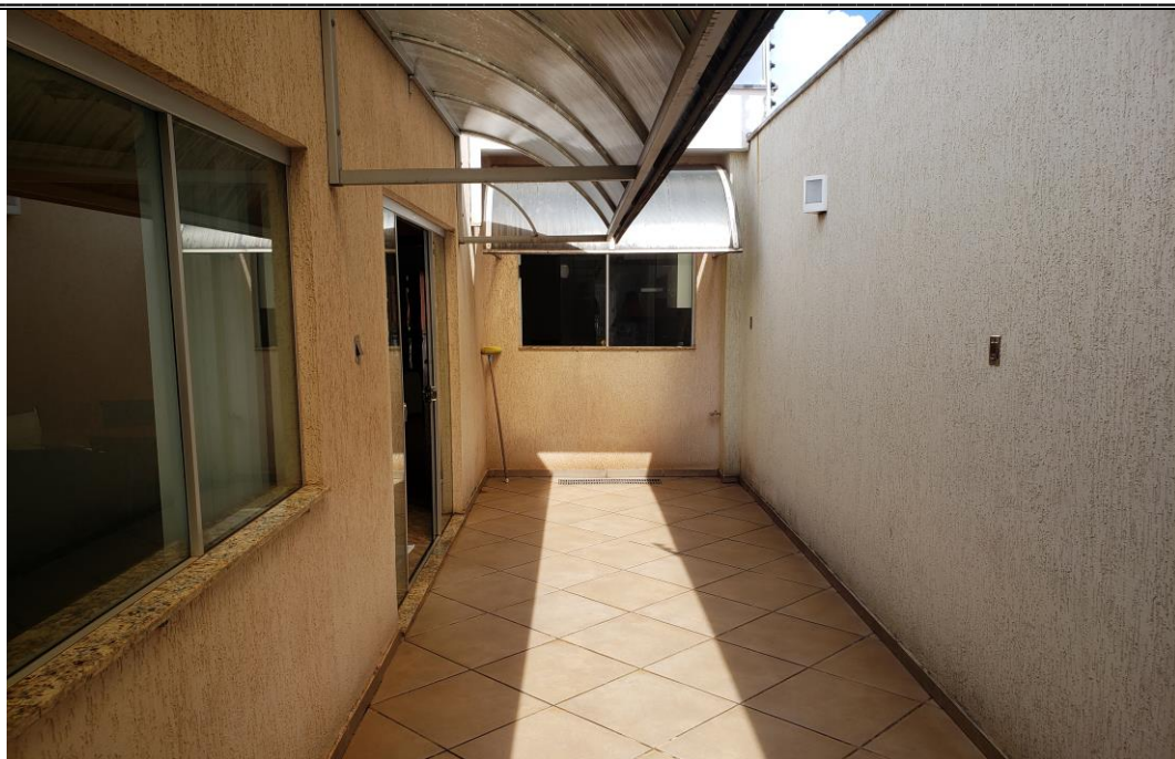
FOTO 03 – vista geral externa lateral do imóvel.
