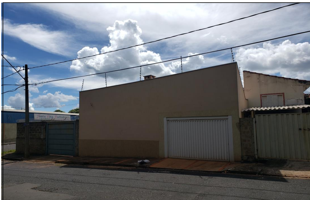
FOTO 16 – vista geral da fachada nos fundos do imóvel com frente para Avenida Antônio Gea Bernar.
