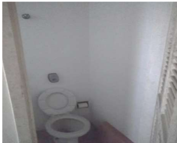
VISTA DO BANHEIRO DA DEPENDÊNCIA DE EMPREGADA.
