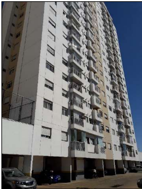
Fotos 01, 02 e 03 – Vista da fachada do Edifício, onde está localizado o apartamento.
