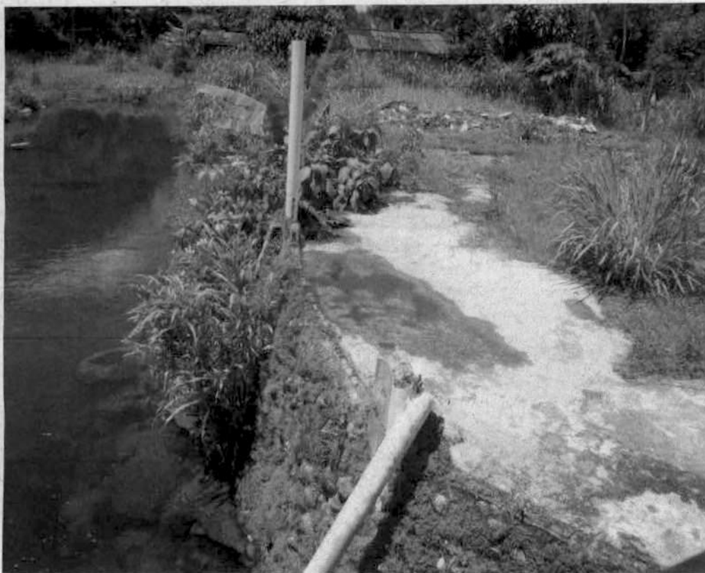
Fotografia de cimentado na margem do rio.
