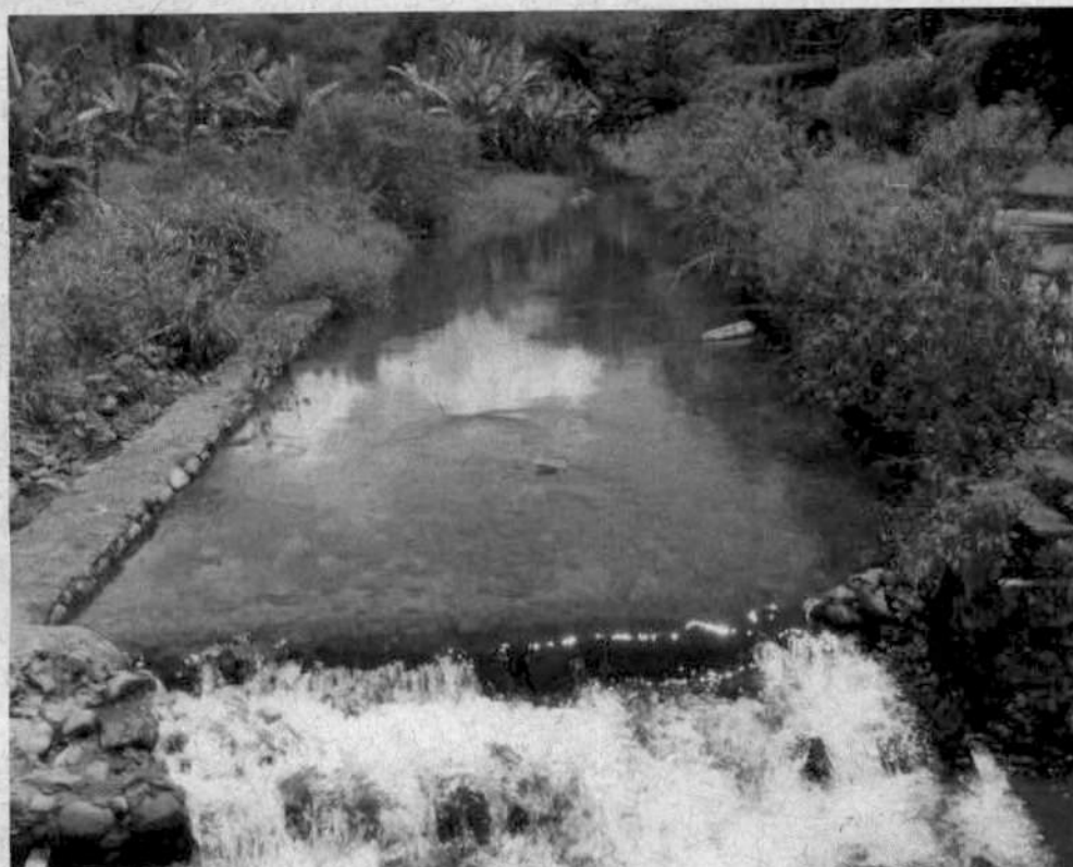
Parte do barramento construído e remanescente na área.
