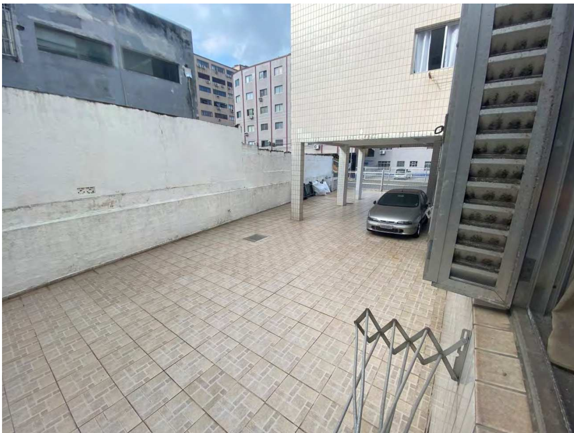
Foto 18: Vista área de estacionamento.
