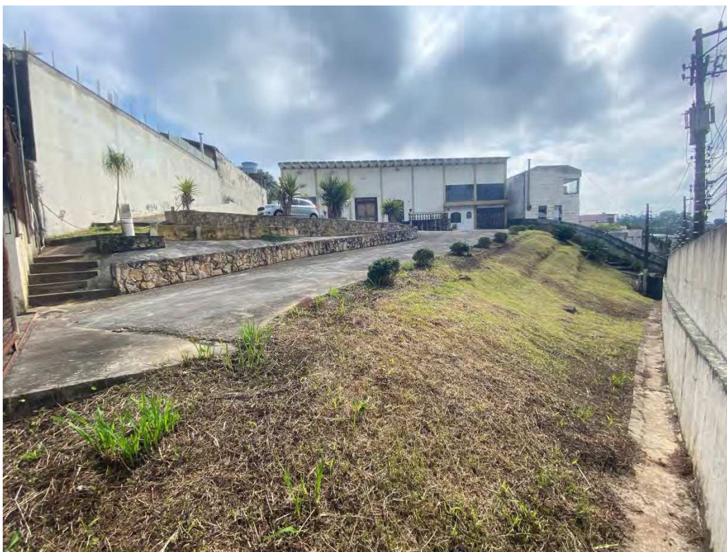
Foto 01: Vista do imóvel desde muro na Estrada do Rio Acima.
