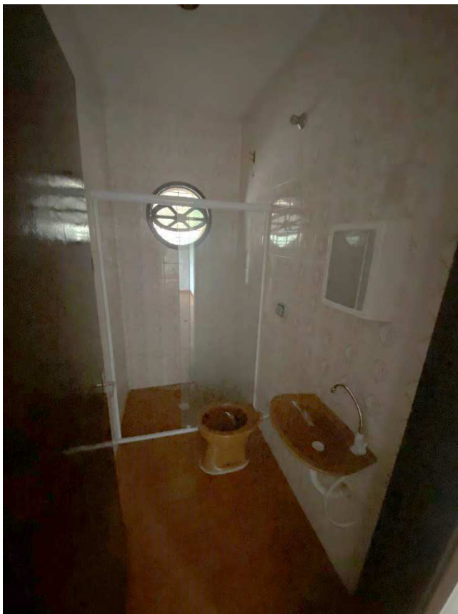
Foto 14: Vista do banheiro.
