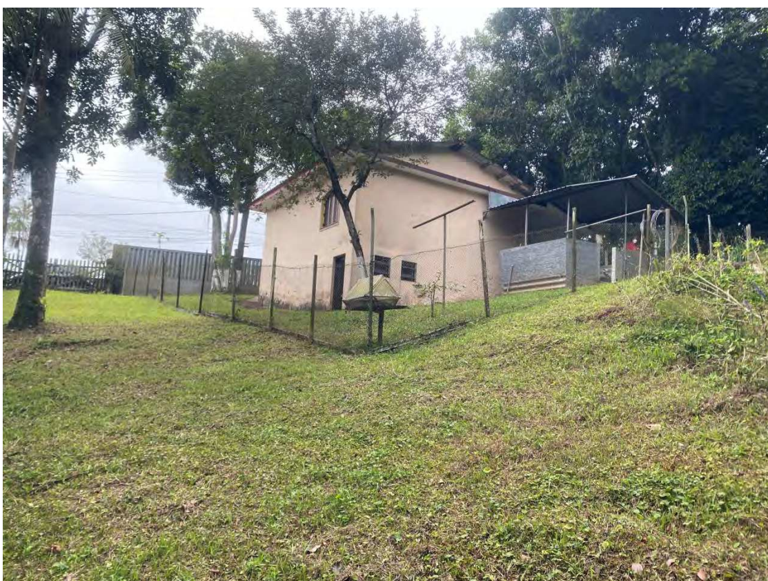
Foto 18: Vista posterior do imóvel mostrando porta do depósito no andar inferior.
