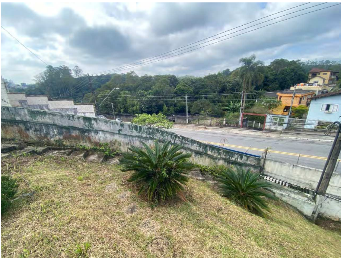
Foto 05: Vista desde área de estacionamento.
