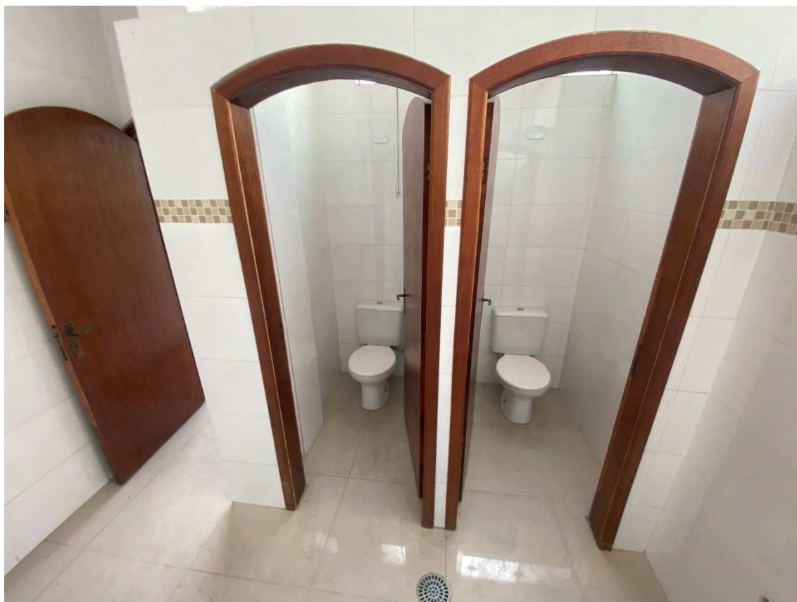
Foto 11: Vista do banheiro masculino.
