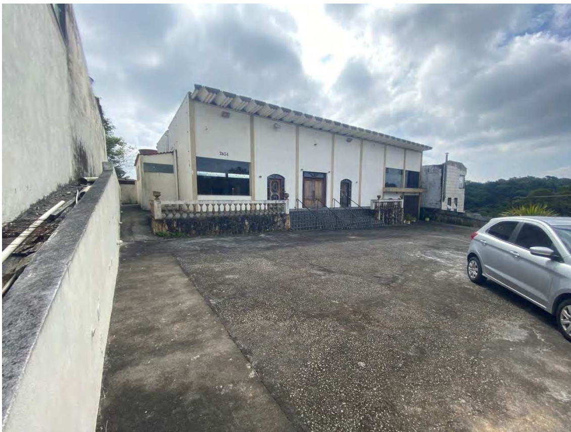
Foto 08: Vista da fachada do imóvel.
