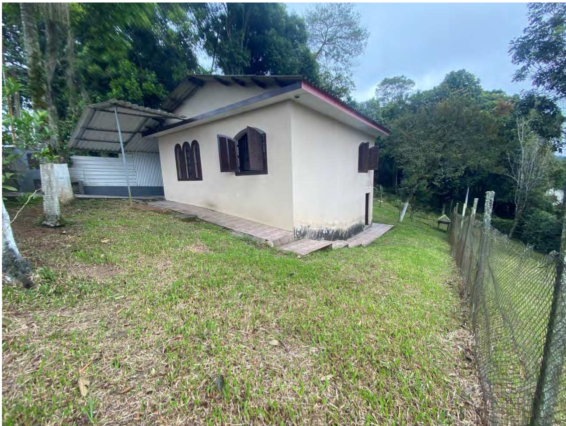
Foto 06: Vista da fachada do imóvel.
