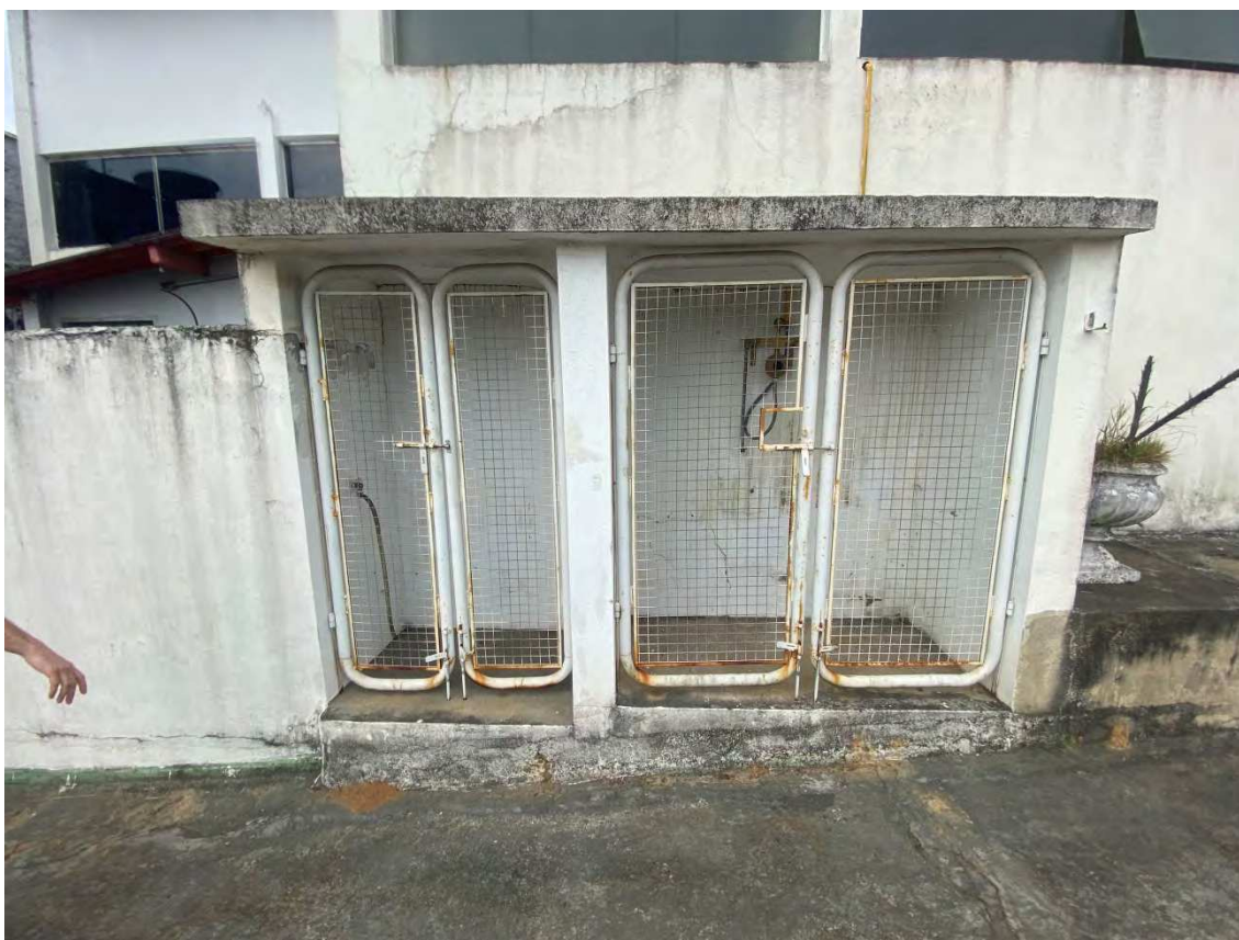
Foto 38: Vista do abrigo de gás.
