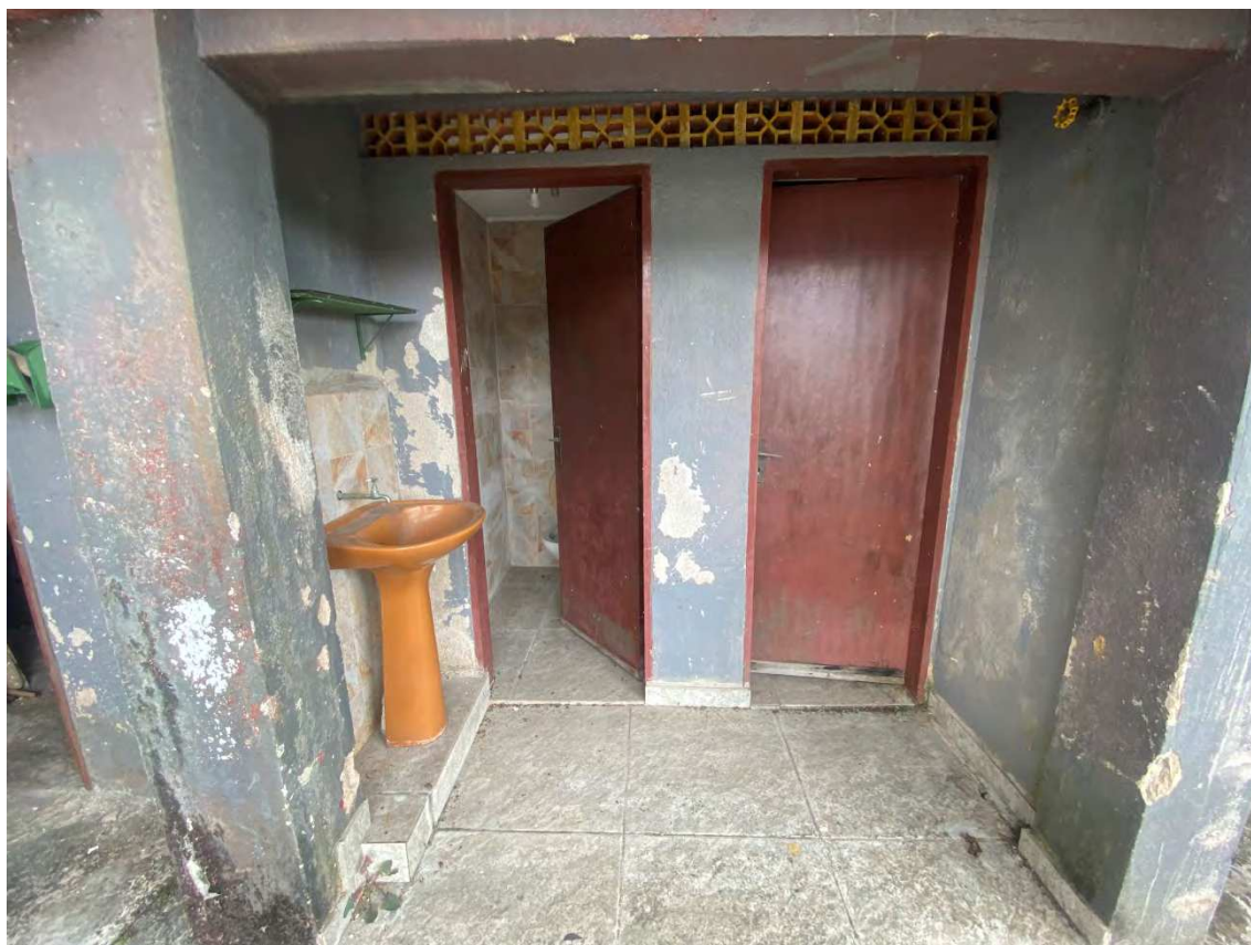
Foto 41: Vista dos banheiros na área externa.
