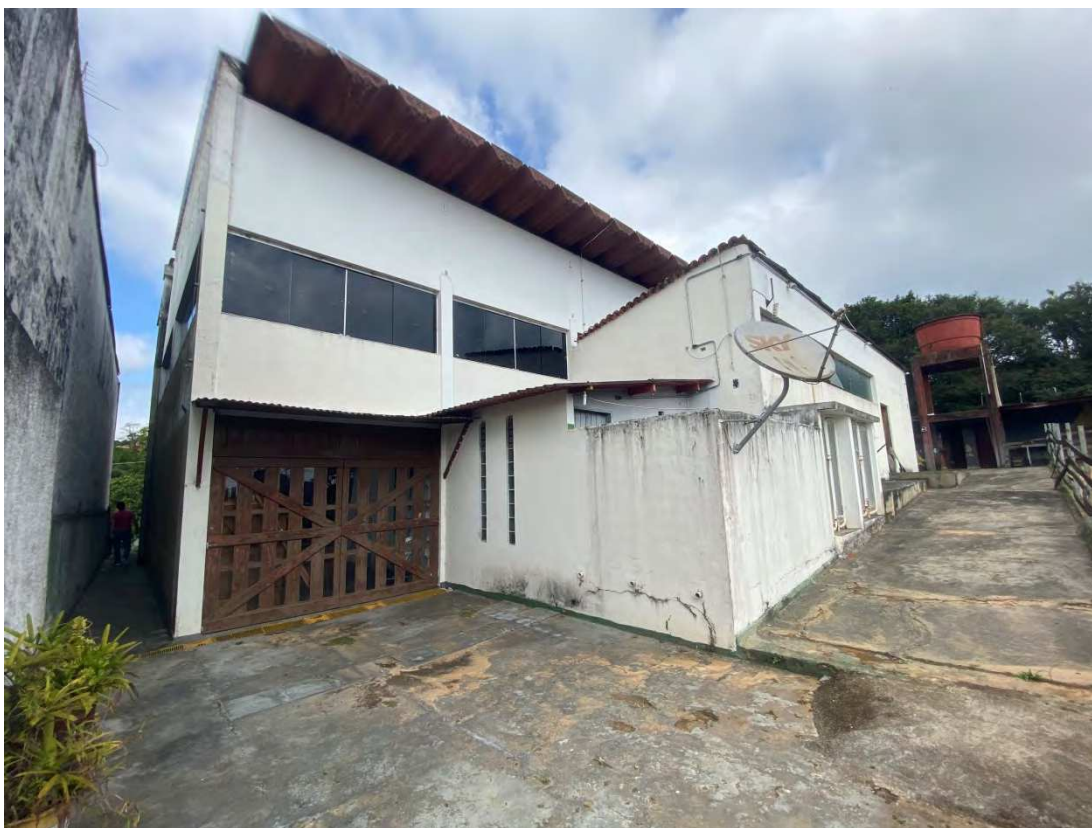
Foto 37: Vista dos fundos do imóvel. Portão de madeira acessa varanda coberta da casa.
