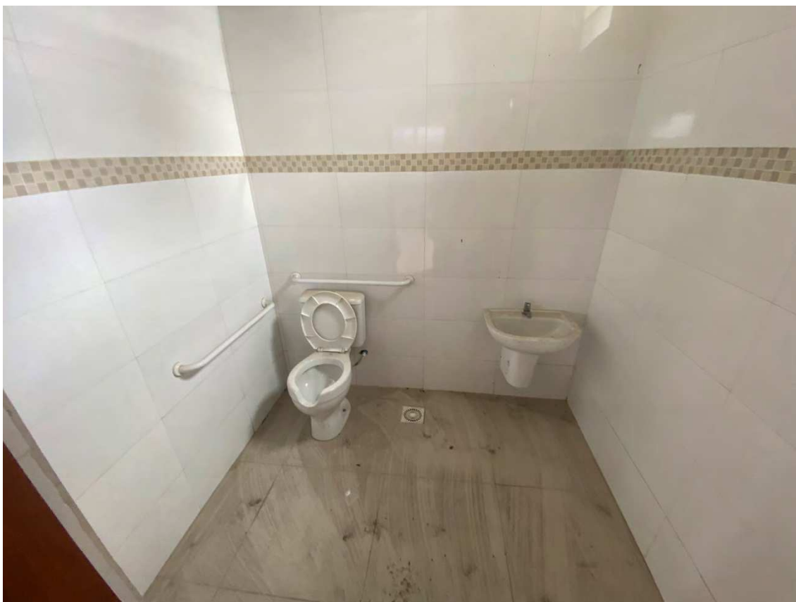
Foto 15: Vista do banheiro PNE.
