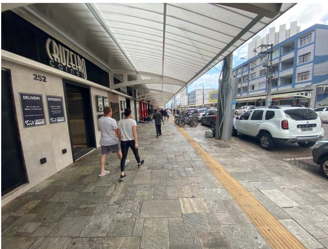
Foto 04: Vista da calçada defronte a entrada do edifício.
