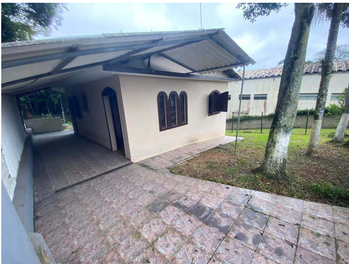
Foto 04: Vista da fachada desde o portão de entrada.
