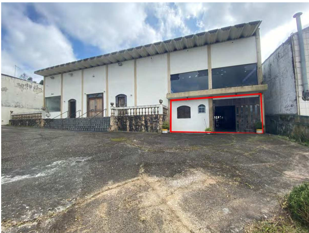
Foto 03: Vista da fachada do imóvel. Porção correspondente a casa destacada em vermelho.
