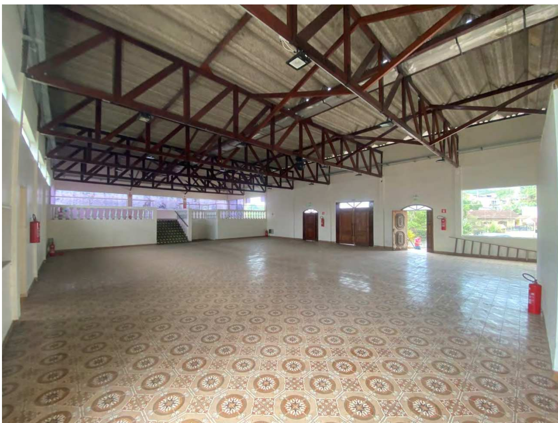
Foto 16: Vista do salão.
