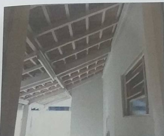
Detalhe da cobertura
