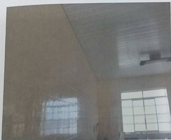
Detalhe do forro da residência
