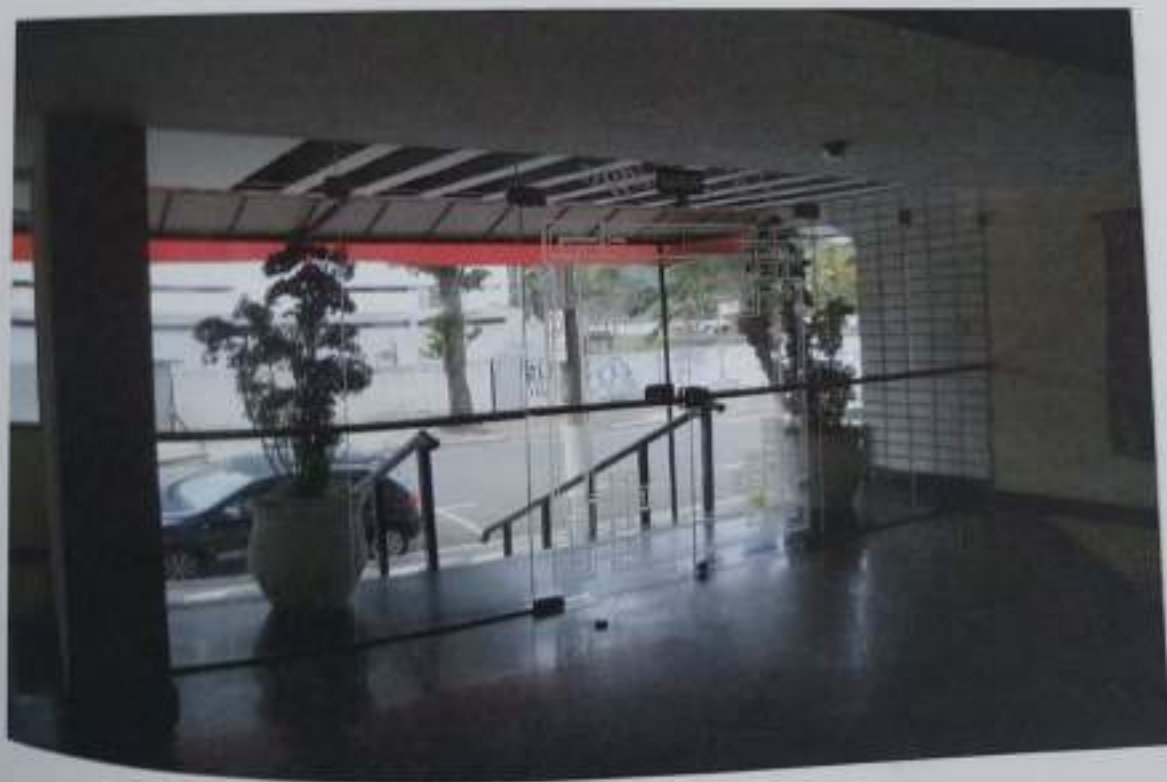
Foto 04 - Detalhe do hall de entrada.
