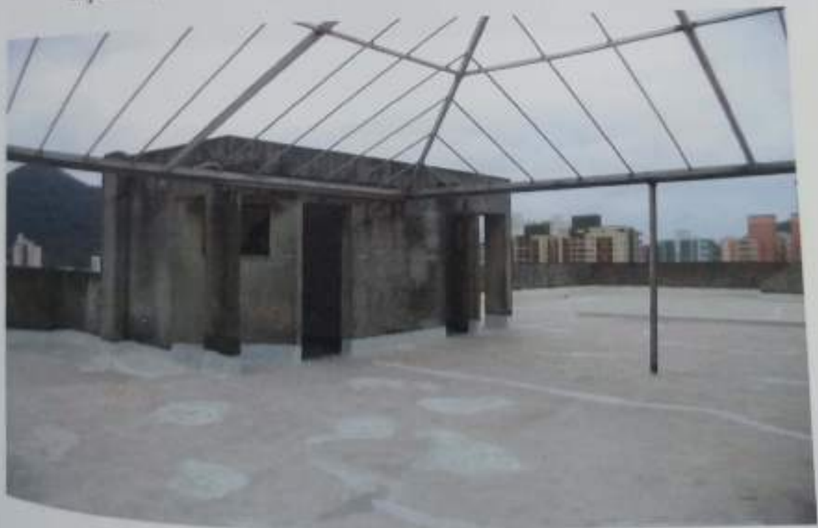
Foto 08 - Detalhe da área livre pertencente ao imóvel em estudos (área de cobertura dos andares superiores).
