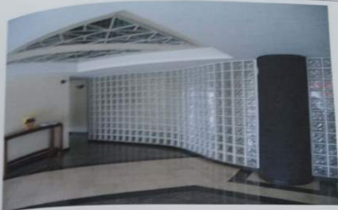
Foto 05 - Detalhe da parede de tijolos de vidro dividindo o hall de entrada.
