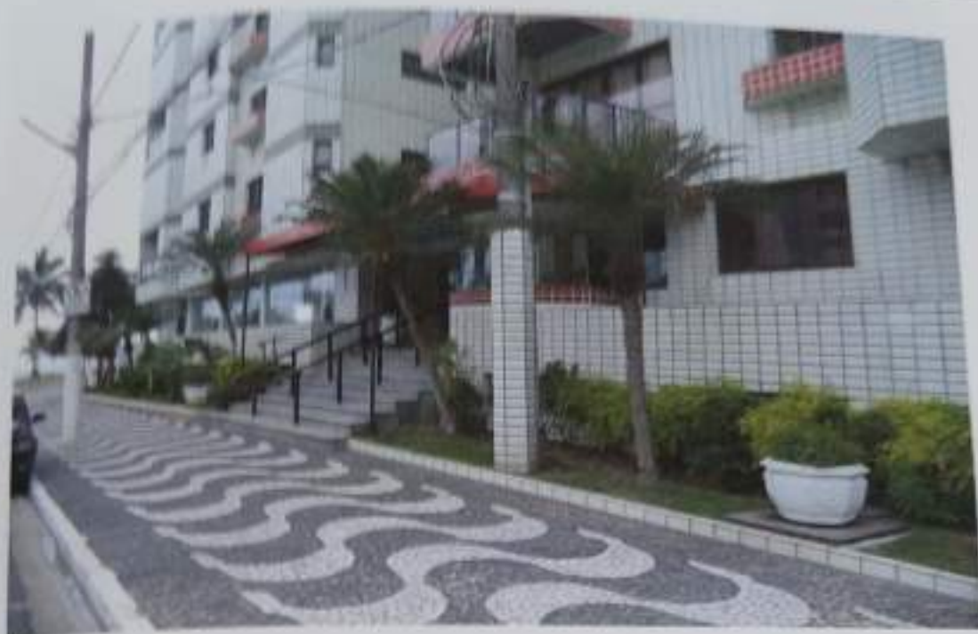
Foto 03 - Detalhe da fachada.
