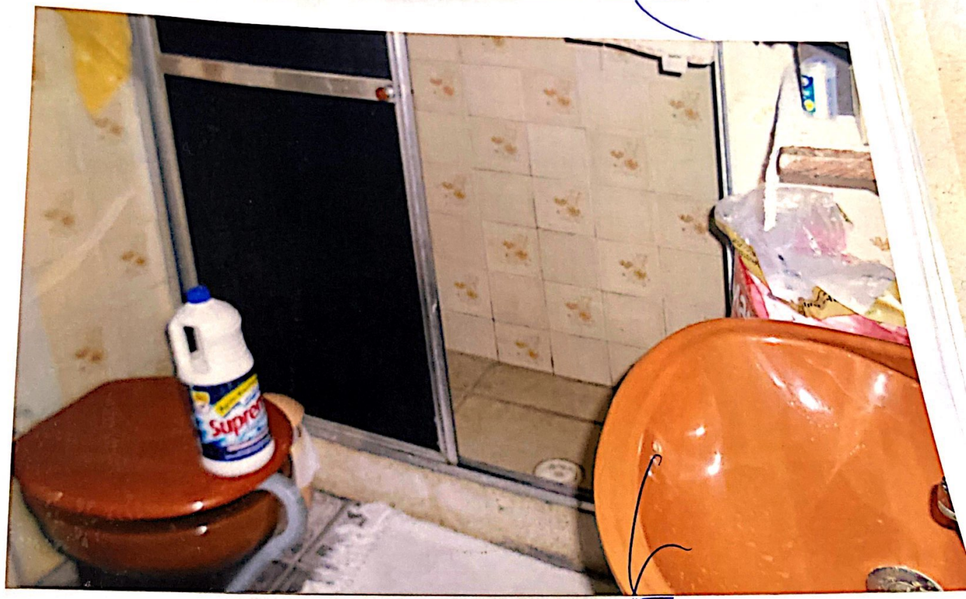
Foto nº 13 – banheiro social com piso cerâmico, paredes com azulejos decorado, louça sanitária de padrão comercial e box de acrílico
