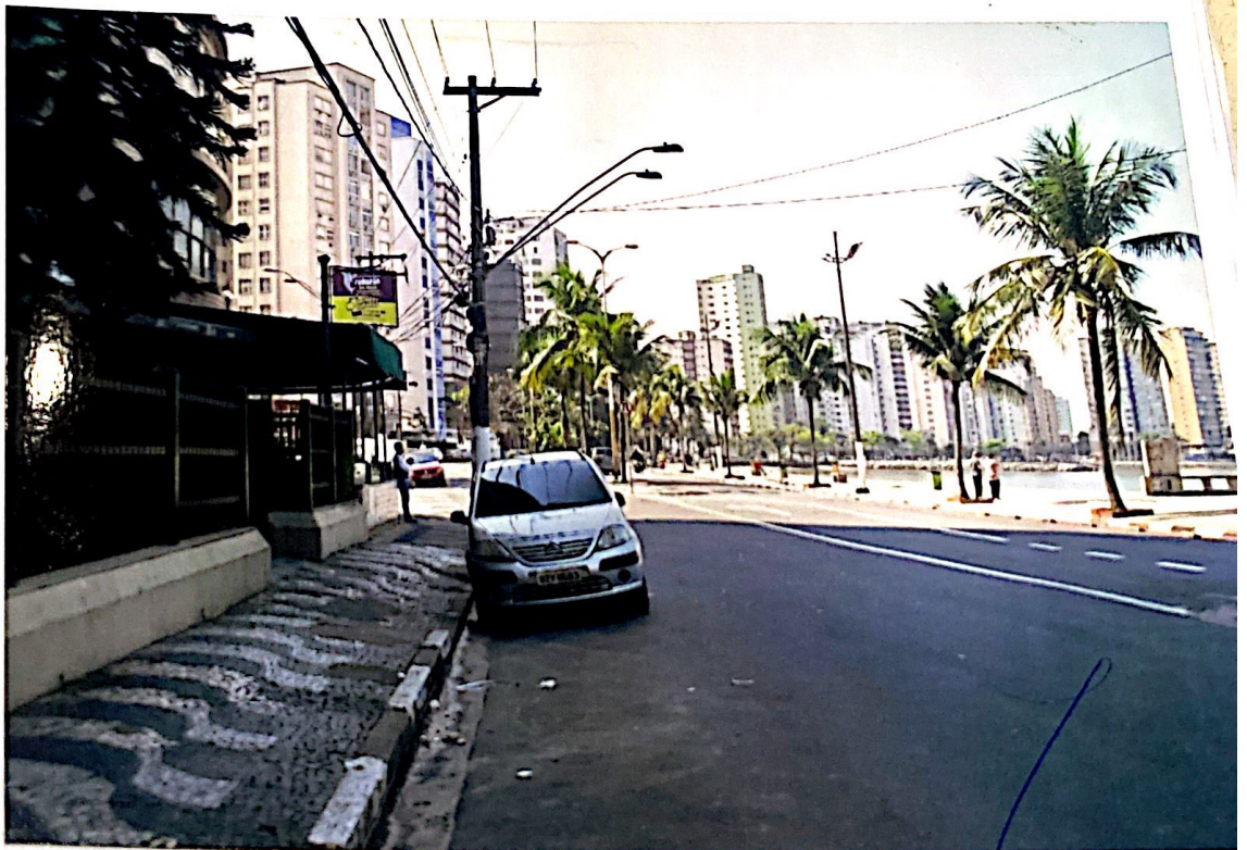
Foto nº 5 detalhe da fachada do EDIFÍCIO COSTA ATLÂNTICA
