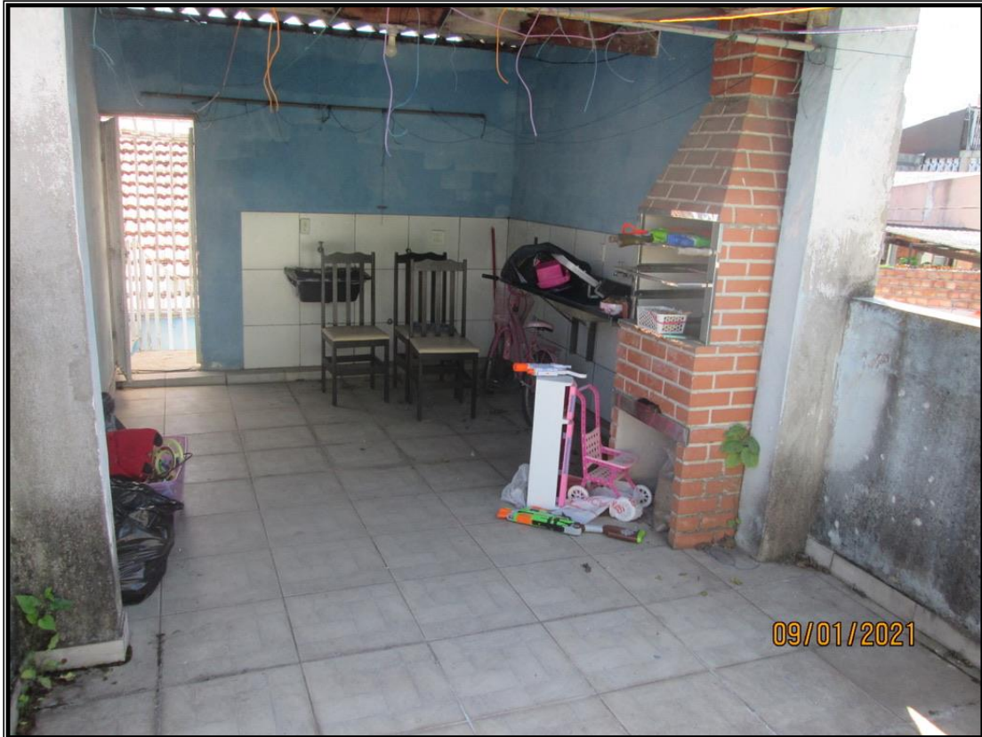
Churrasqueira do imóvel com simples cobertura, com acesso pelo 2º pavimento.
