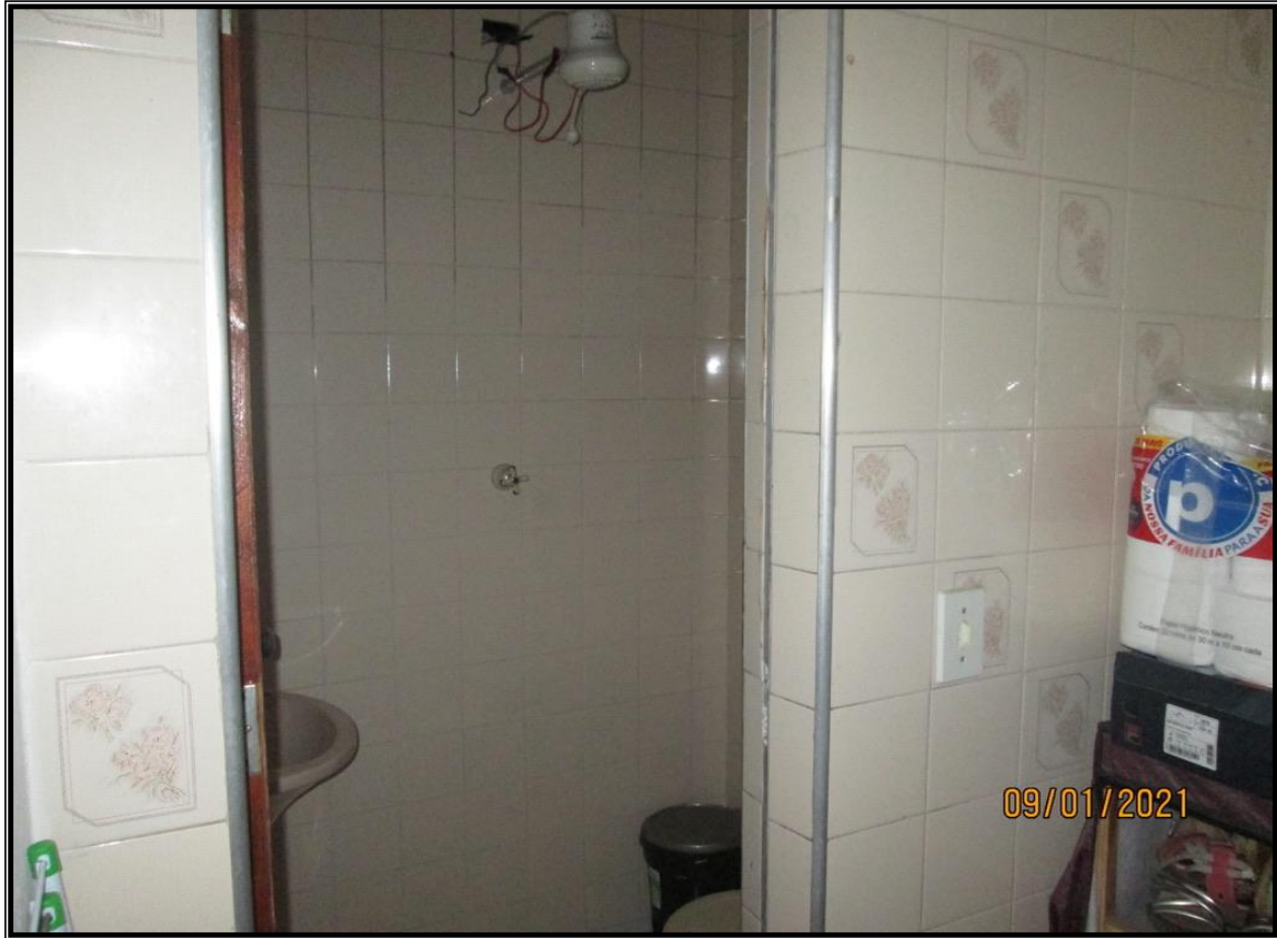
Banheiro 2 (dois) do 1º pavimento.
