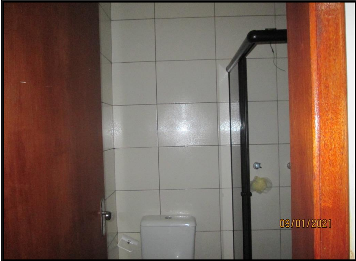
Banheiro 1 (um) do 1º pavimento.
