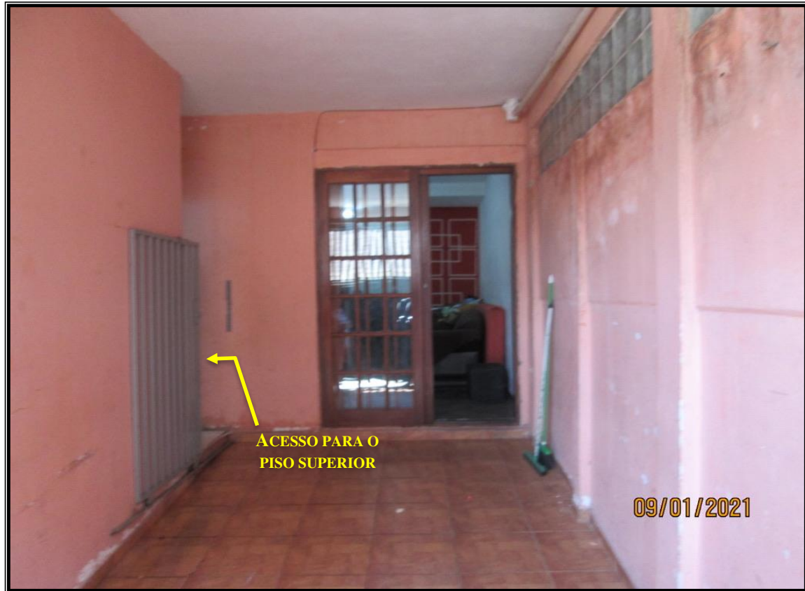
Garagem do imóvel - Aos fundos sala do 1º pavimento.
