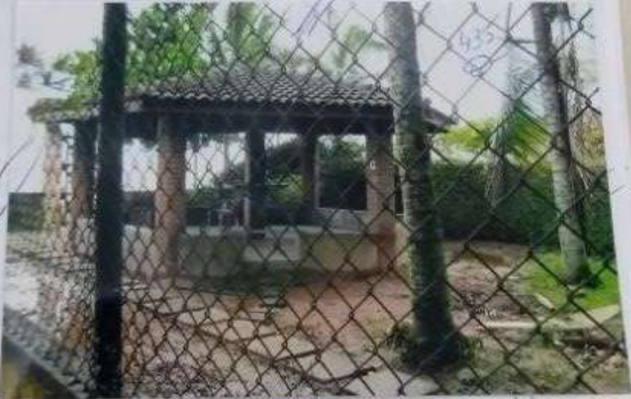
foto nº 16 - caramanchão existente no pátio dos fundos com cobertura de telha cerâmica.
