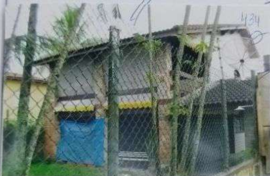
Foto nº 13 - fachada dos fundos do imóvel avaliado, sendo no térreo: terraço coberto e área de serviço; no piso superior: área de churrasqueira.
