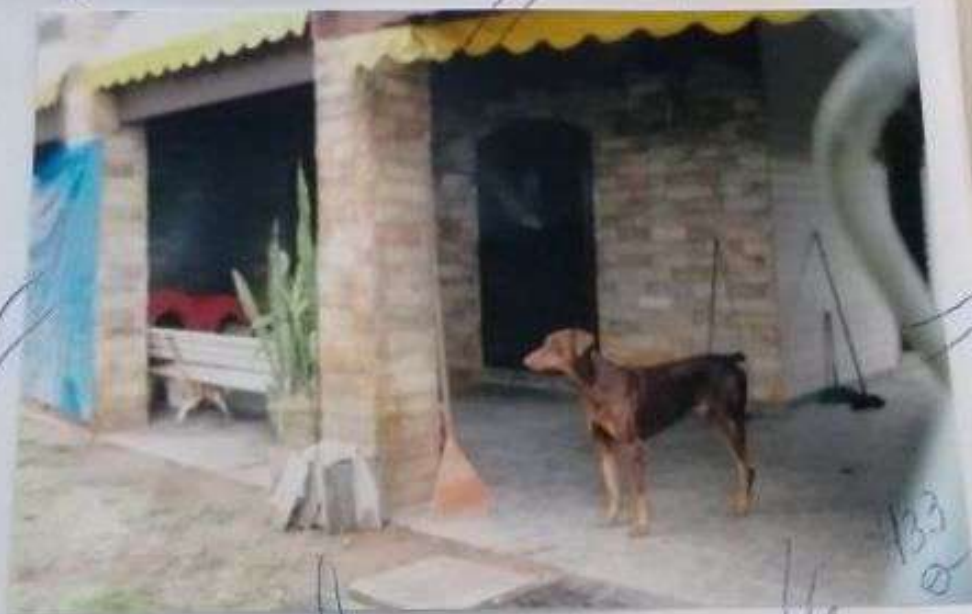
Foto nº 14 - detalhe da área de serviço com piso cerâmico e paredes revestidas de pedras.
