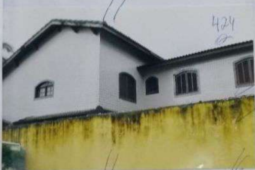
Foto nº 3 - detalhe da fachada lateral com detalhes das janelas de venezianas de madeira.
