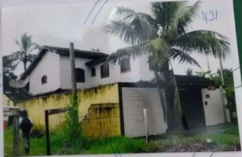
Foto nº 02 - Fachada lateral do sobrado avaliando com paredes externas revestidas de cerâmica.
