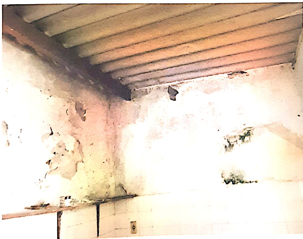
Foto 10- Vista parcial da lavanderia.
