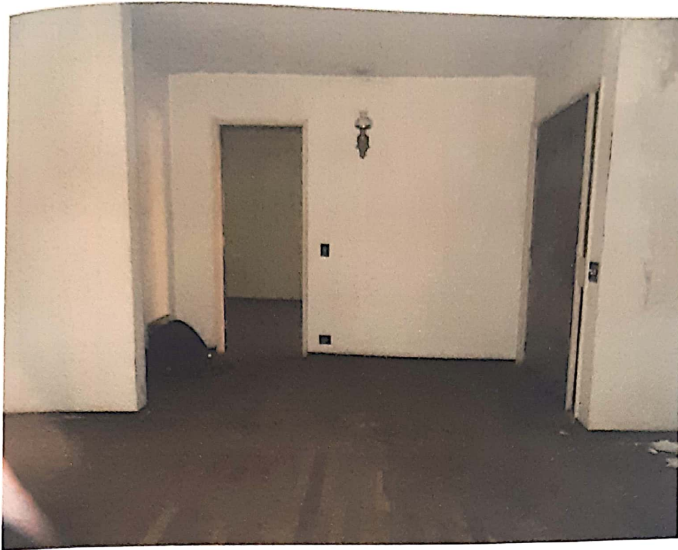
Foto 3- Vista parcial da sala.
