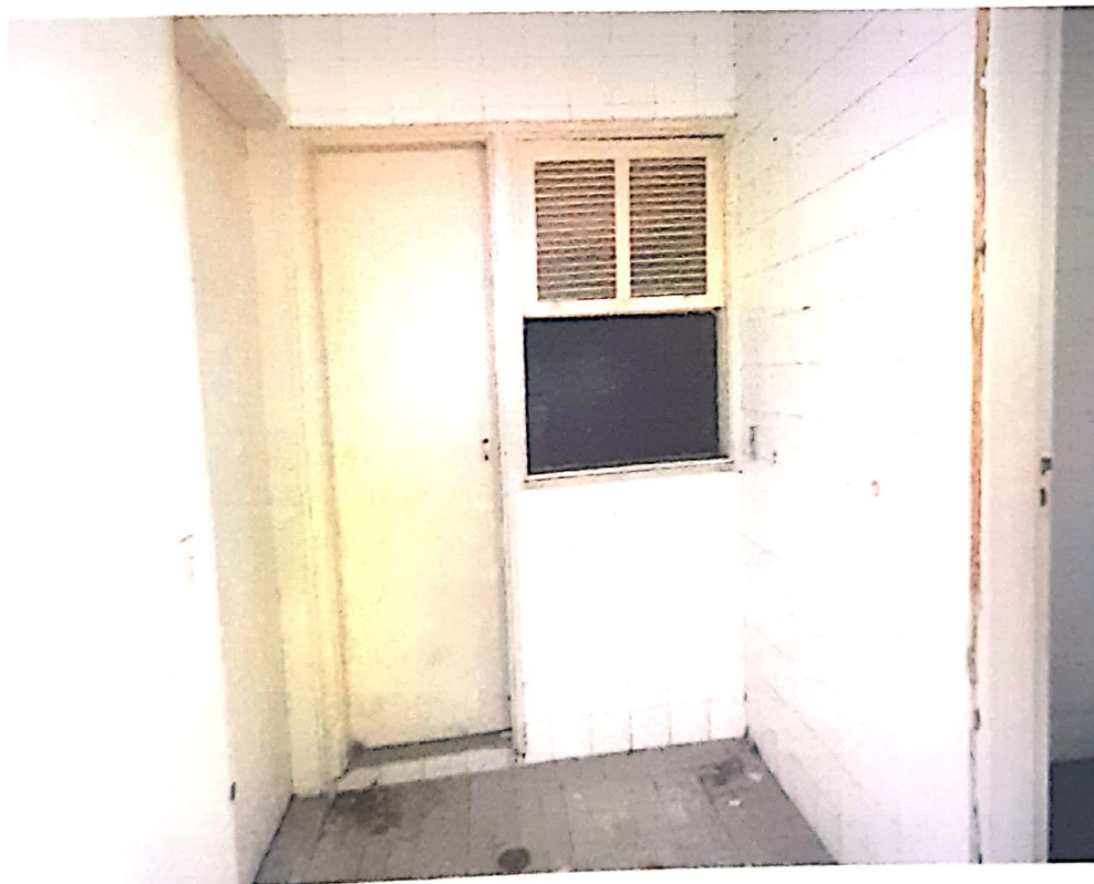
Foto 12- Vista da passagem da cozinha para o quarto/banheiro de empregada.
