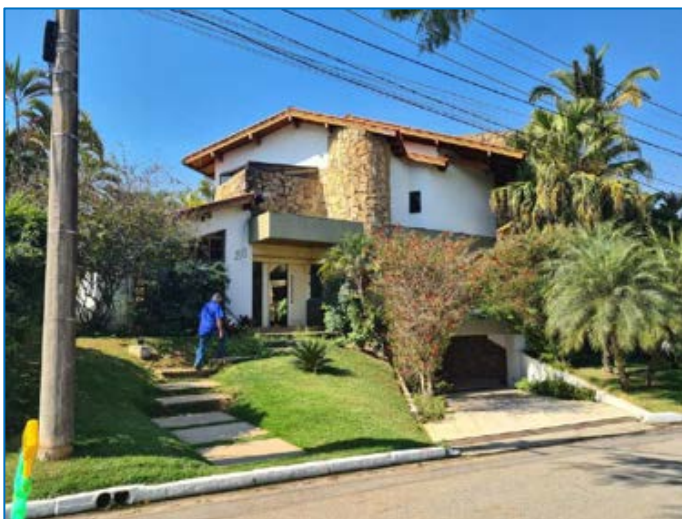
FACHADA DO IMÓVEL AVALIANDO.
