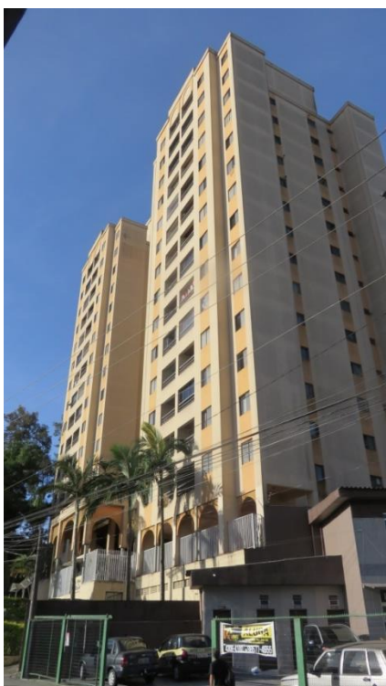
Figura 6: Vista geral externa do condomínio
