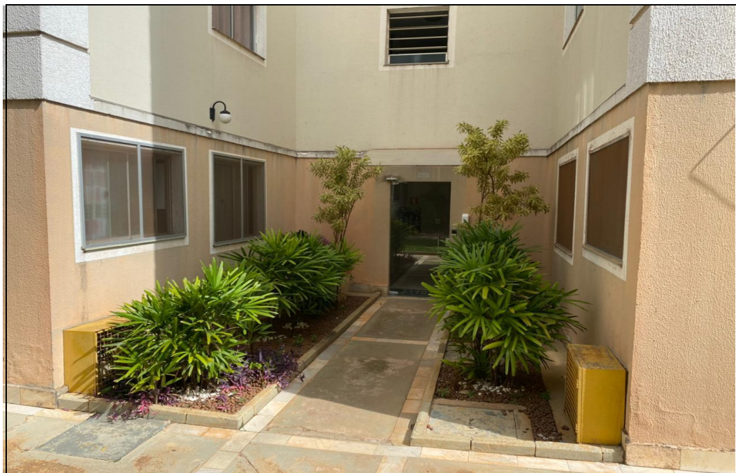
FOTO 02 – Vista geral da porta de entrada do bloco 06.
