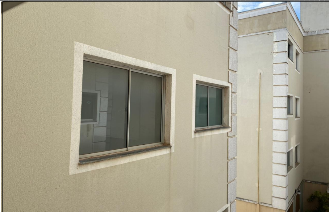
FOTO 03 – Vista externa da esquadria lateral do imóvel.
