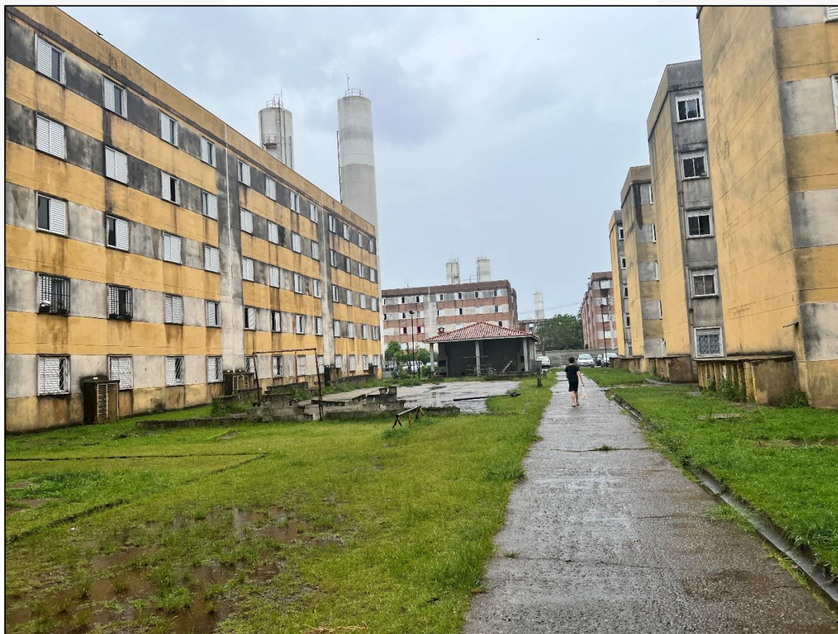
VISTA DA FACHADA DO IMÓVEL AVALIANDO.
