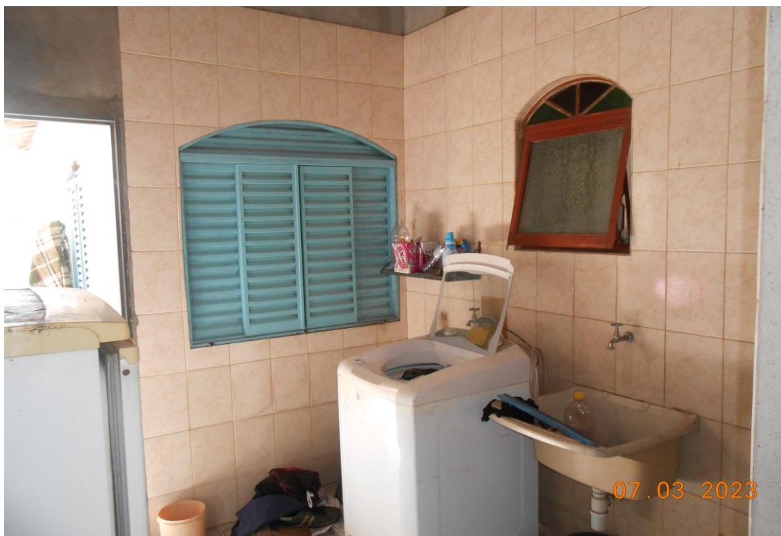
Foto 5: Vista da área de serviço.
