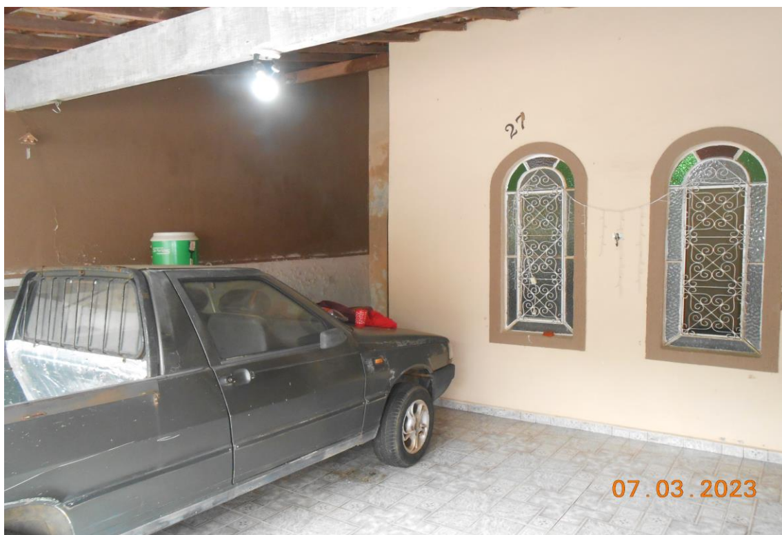
Foto 2: Vista do abrigo para veículo.
