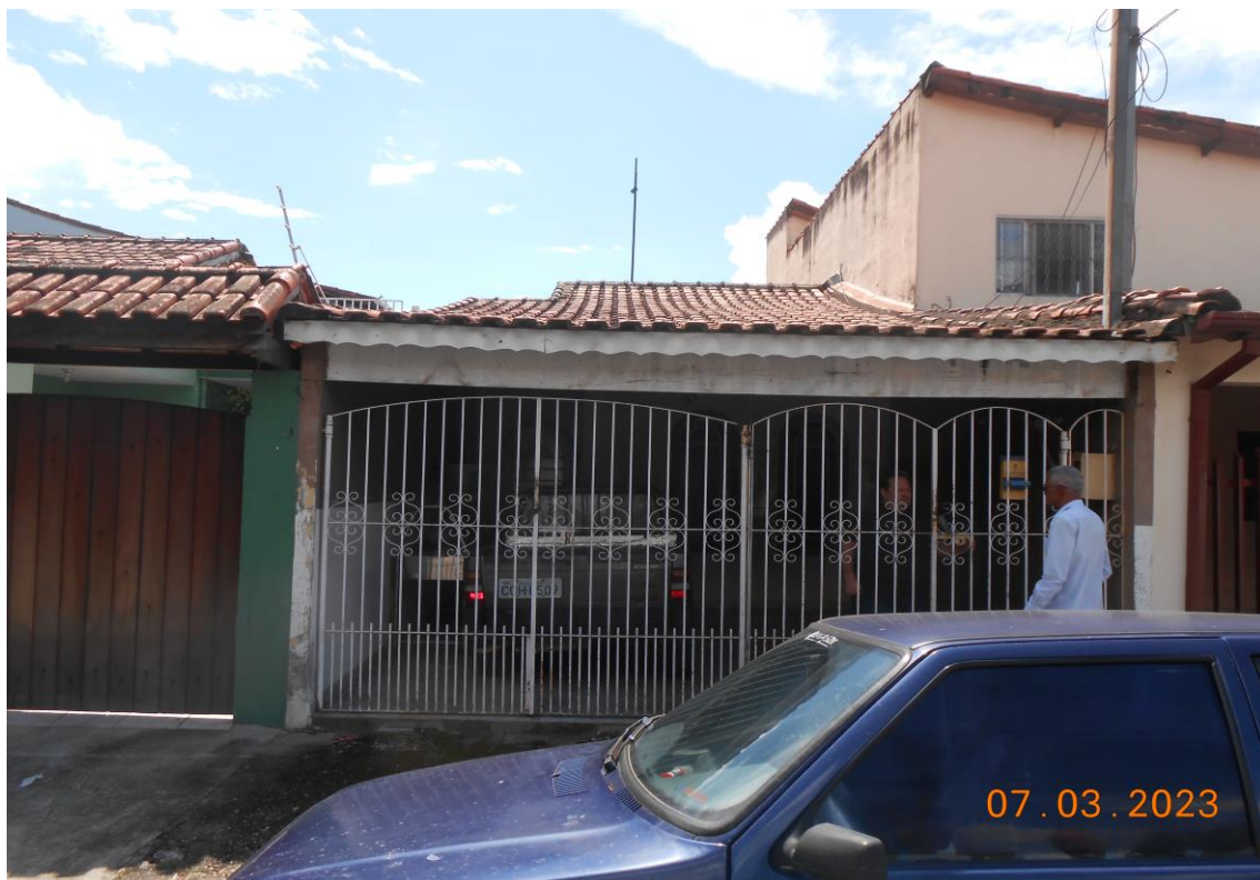
Foto 1: Vista frontal do imóvel avaliando.
