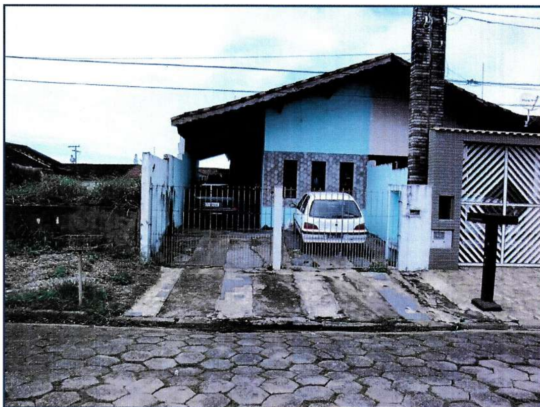
Fachada da residência
