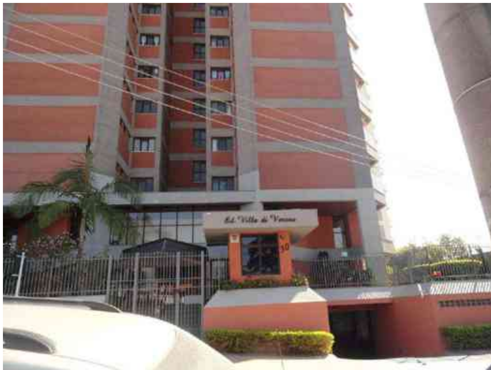
Foto nº 01 – Vista da Edifício Villa Di Verona.
