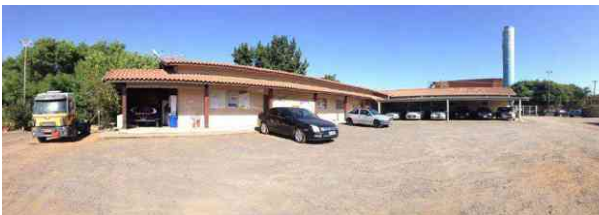
Visão Panorâmica do Prédio Administrativo
