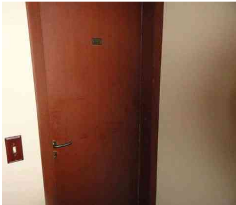
Foto nº 03 – Identificação da unidade vistoriada.
