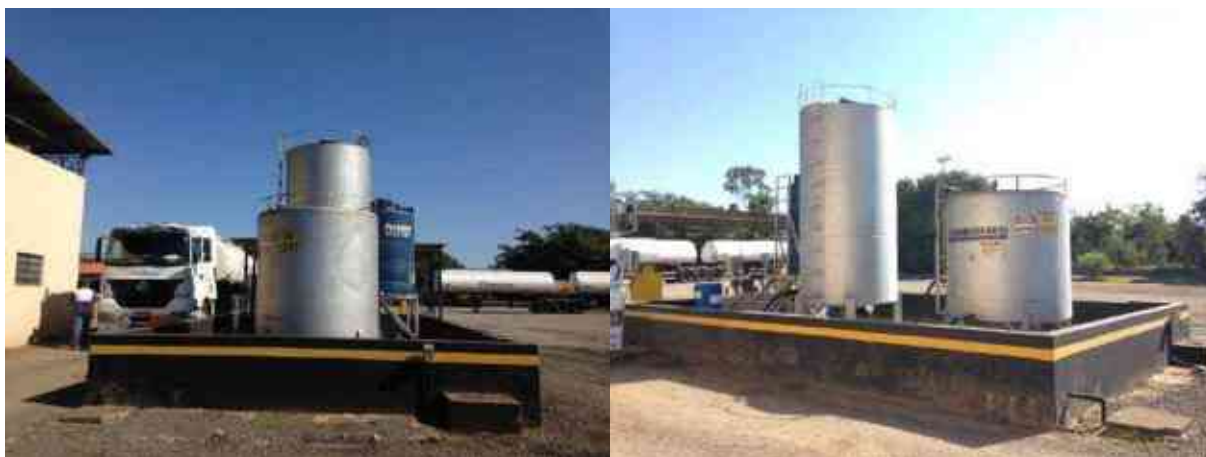
Setor de Abastecimento no imóvel avaliado
