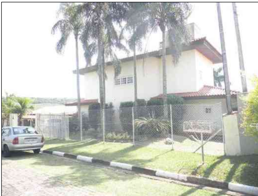
Imagem 08: Fachada do imóvel
