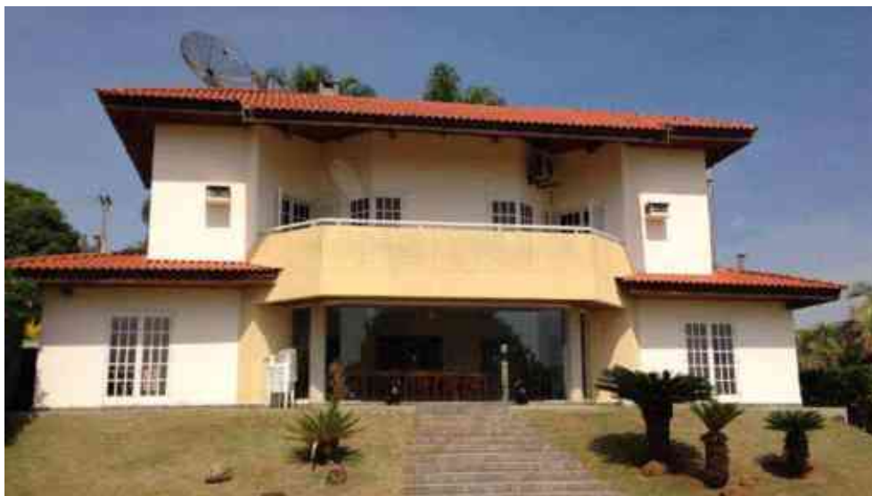
Fundo da benfeitoria do imóvel, com vedação da área gourmet em parede de vidro
