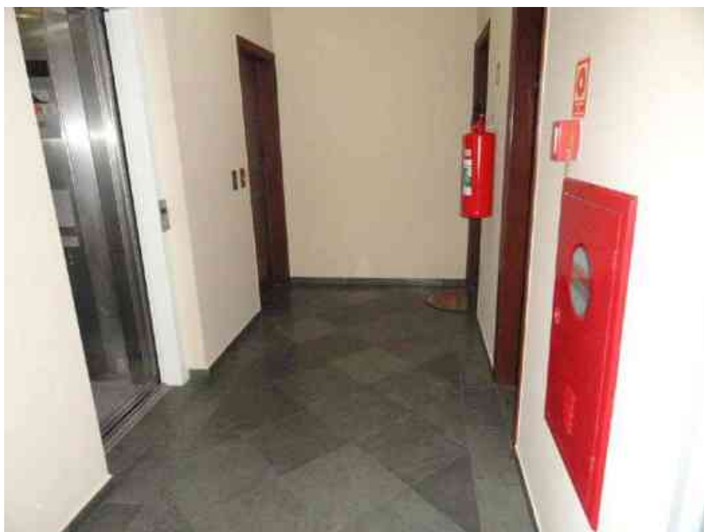
Foto nº 02 – Hall social do 11º andar.
