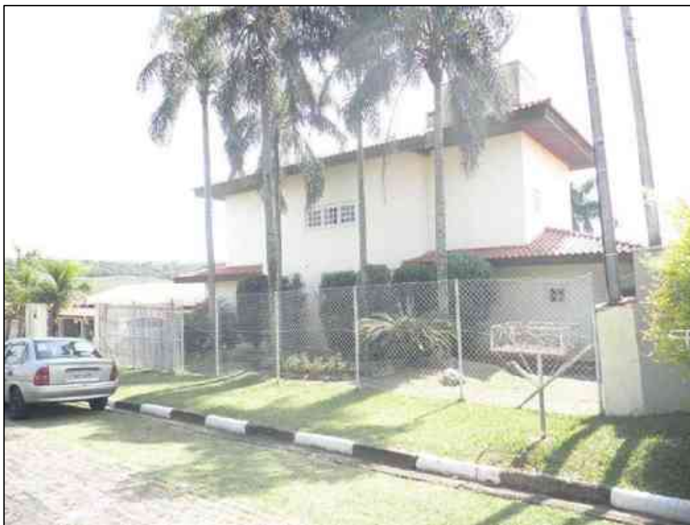
Imagem 08: Fachada do imóvel
