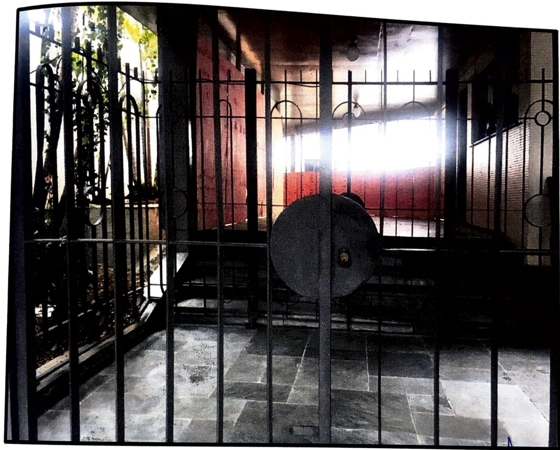
Foto nº 09 – Vista do hall de entrada social.
