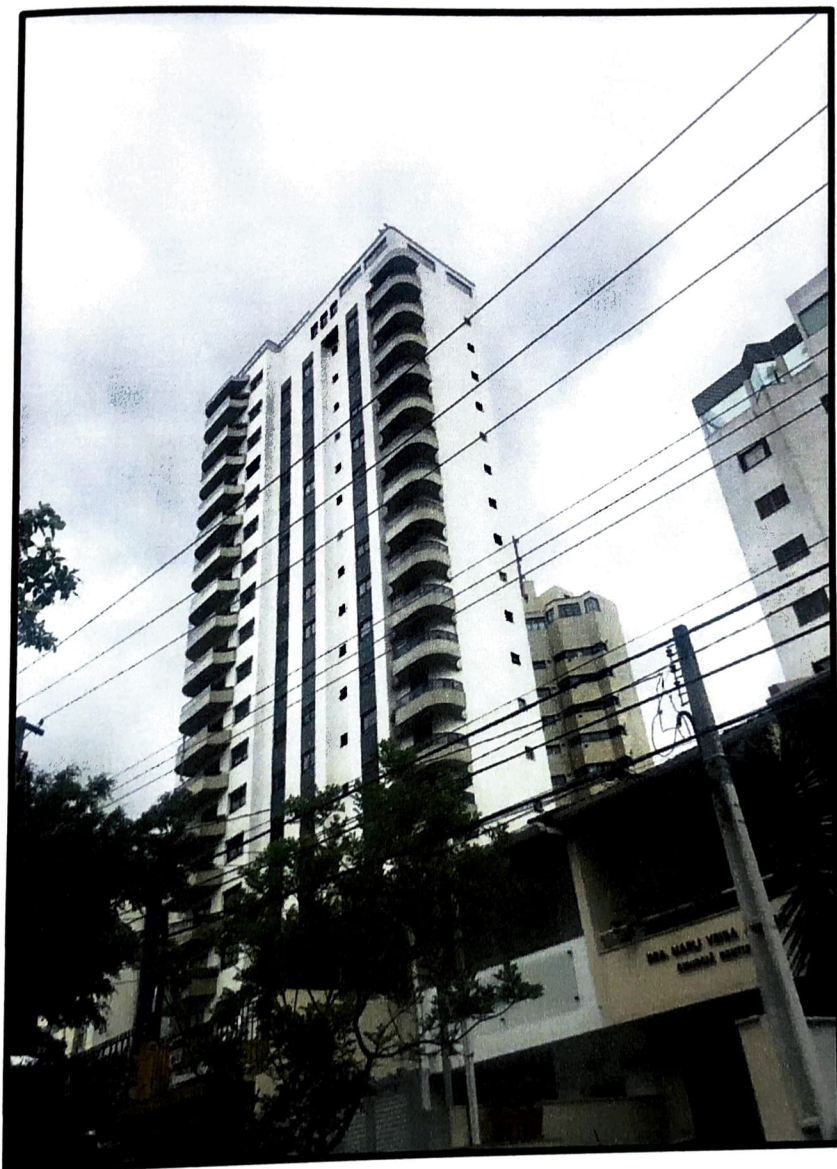
Foto nº 03 – Vista da fachada frontal do edifício.
