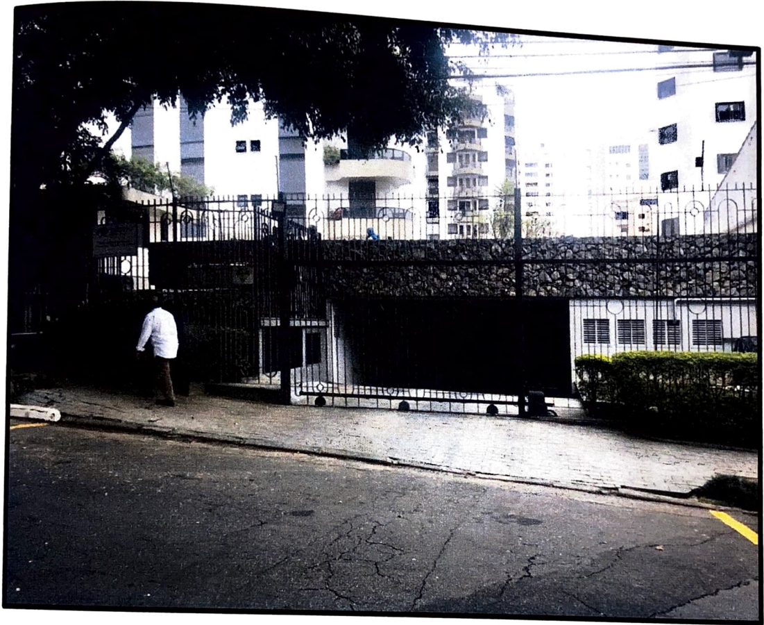
Foto nº 06 – Ilustra o portão de entrada/saída para veículos.
