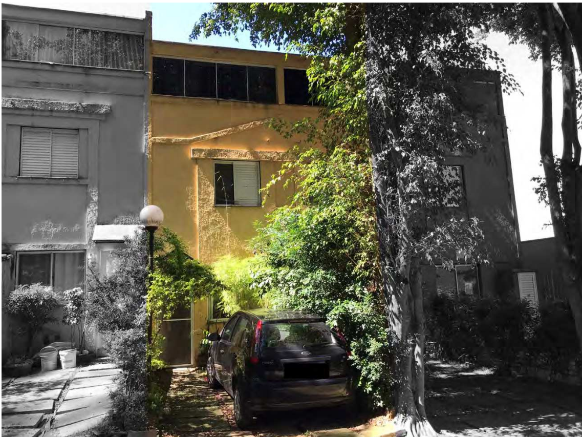
Foto 18: Vista da fachada do imóvel avaliando.
