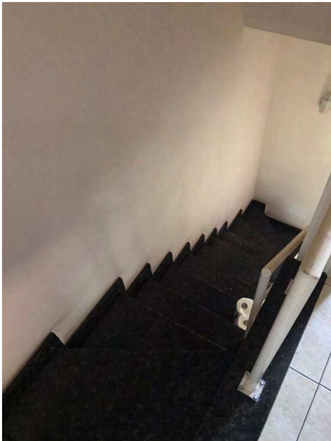
Foto 44: Vista da escada desde segundo andar.
