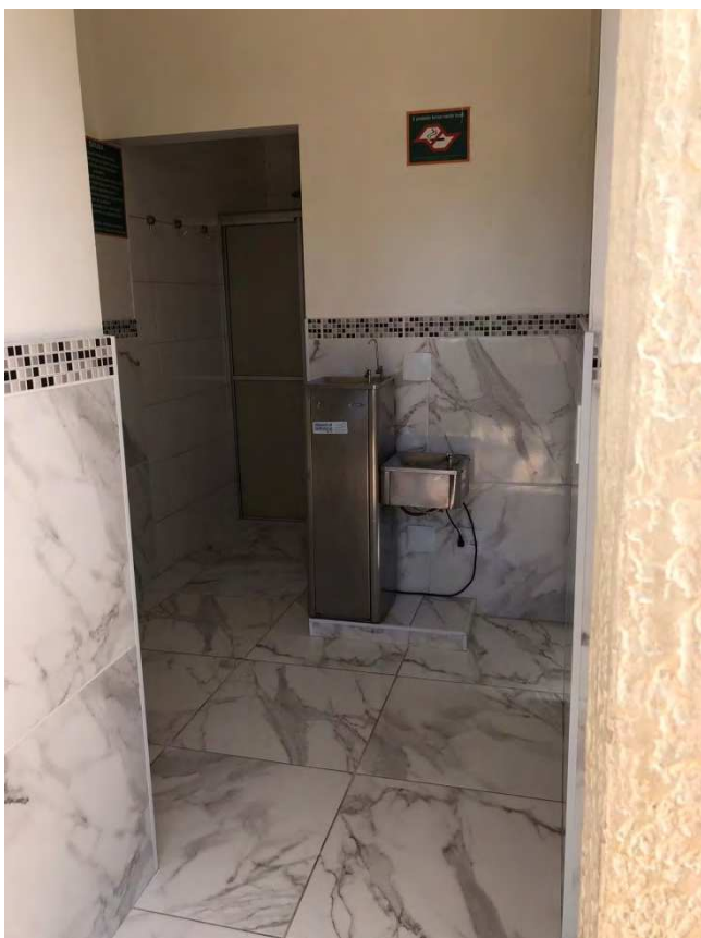
Foto 11: Vista dos sanitários da área da piscina.
