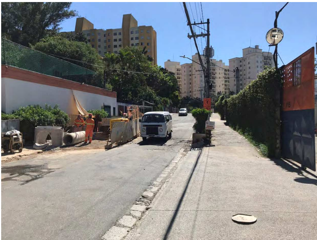
Foto 02: Vista da Rua Giovanni Carnovalli sentido oeste.
