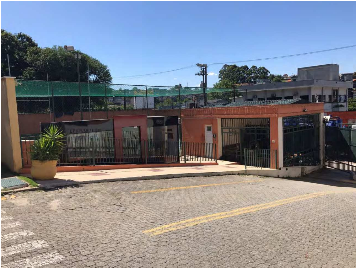
Foto 05: Vista da portaria e lojinha automática.
