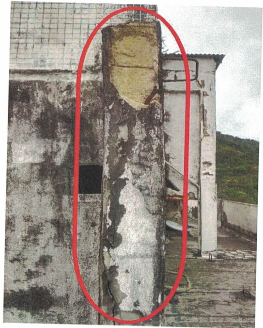
Pilar de sustentação (caixa d'água) - 02
