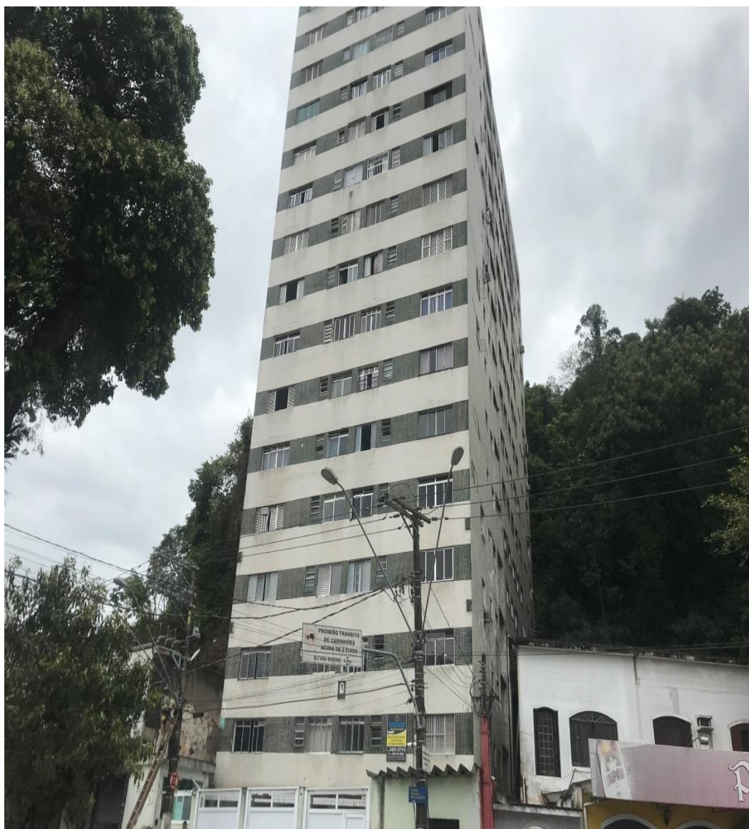
Foto 1 - Vista da fachada frontal do Edifício Prainha
