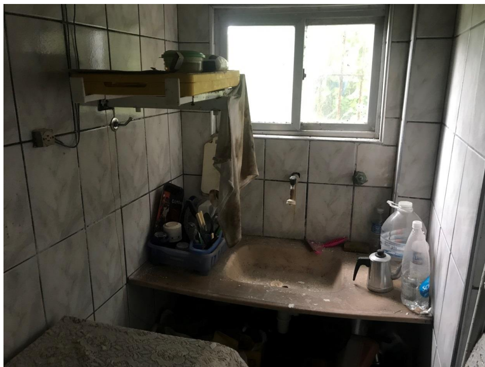
Foto 14 - Detalhe da pia da cozinha; tampo e cuba em mármore sintético
