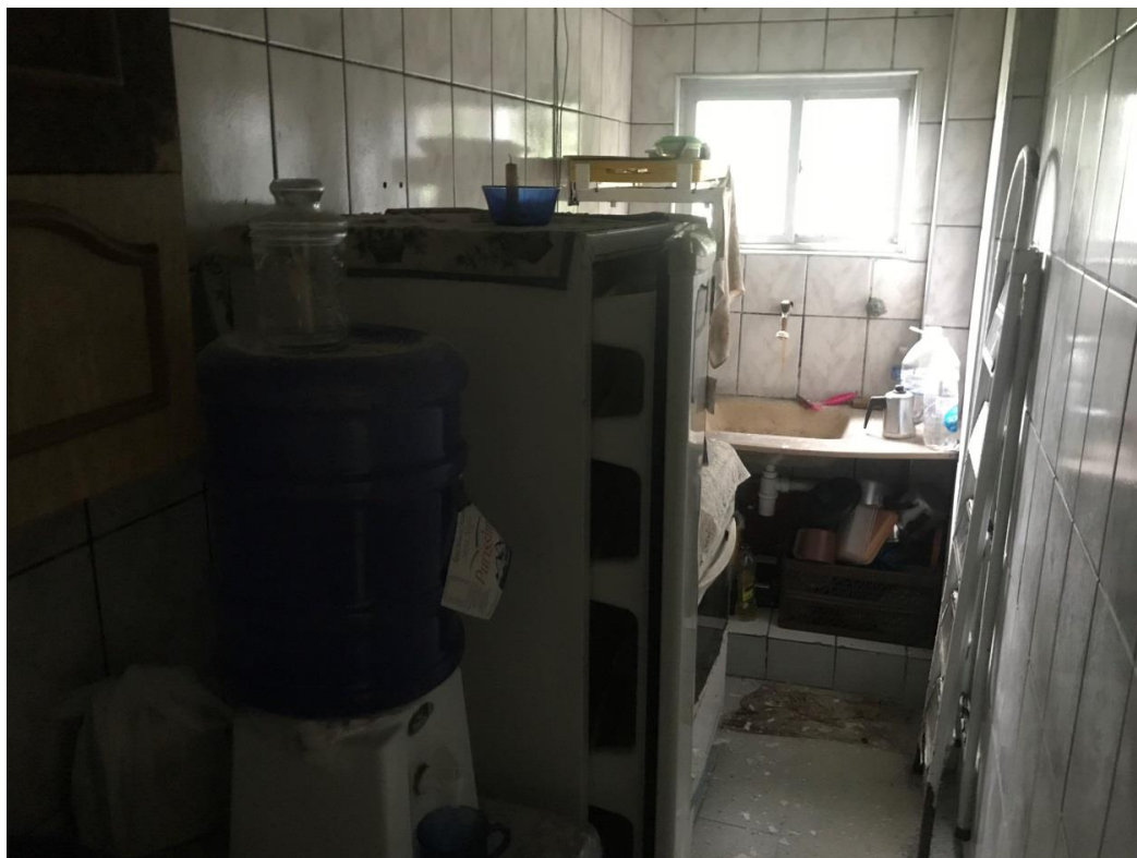
Foto 13 - Vista da cozinha; revestimento com azulejos até o teto e estado geral regular
