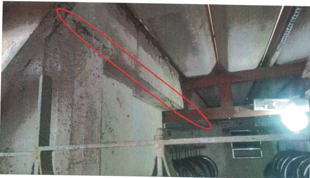
Estrutura externa (garagem)- 01
