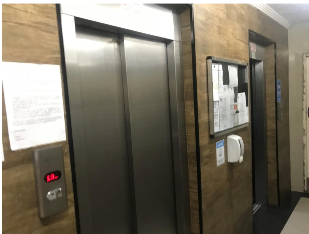
Foto 7 - Hall dos elevadores social e de serviço
