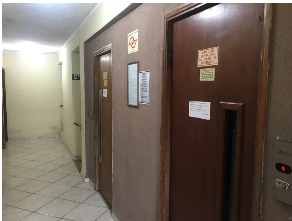
Foto 8 - Elevadores social e de serviço no andar do imóvel avaliando
