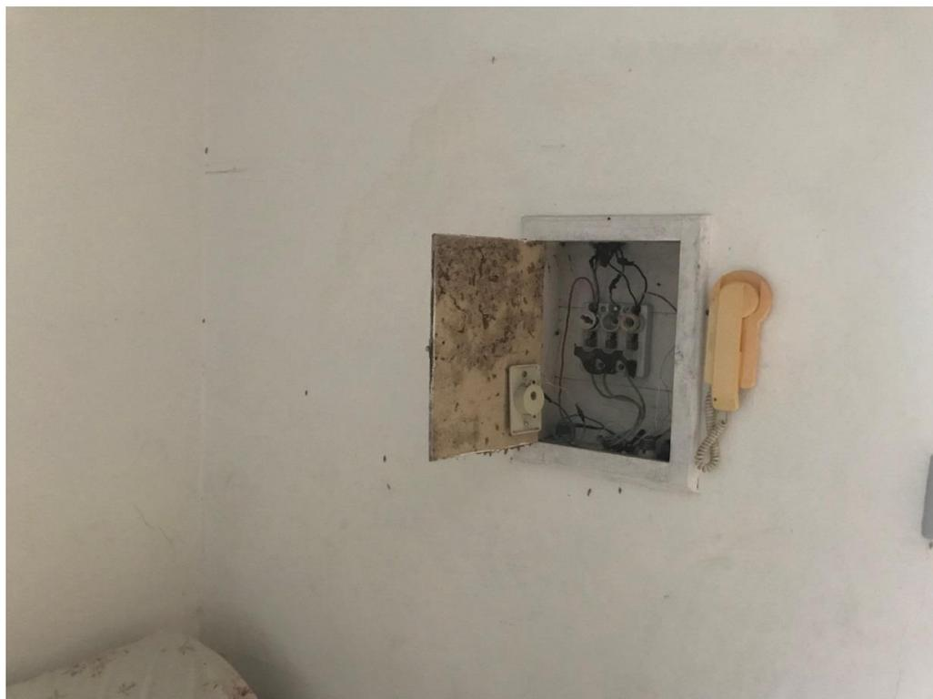
**Foto 21 - Detalhe do quadro de disjuntores, totalmente incompatível com as normas técnicas vigentes e de segurança**
