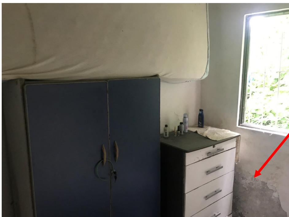
**Foto 17 - Revestimento da parede do quarto danificado**
