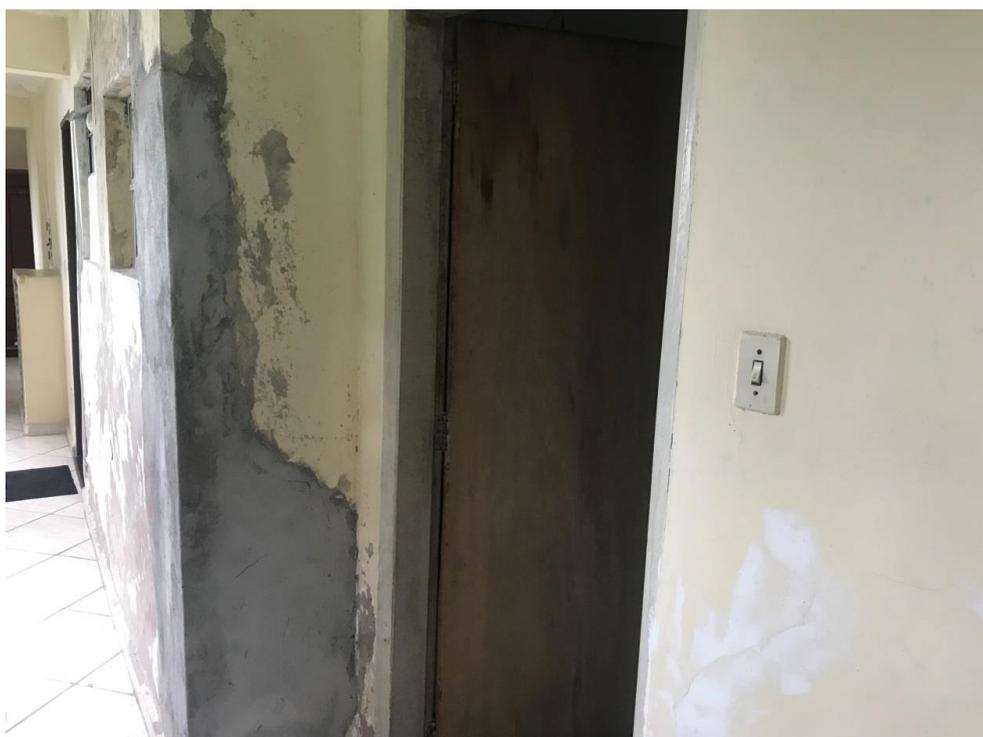
**Foto 10 - Porta de entrada do apartamento 406; revestimento da parede foi rebocado recentemente**
