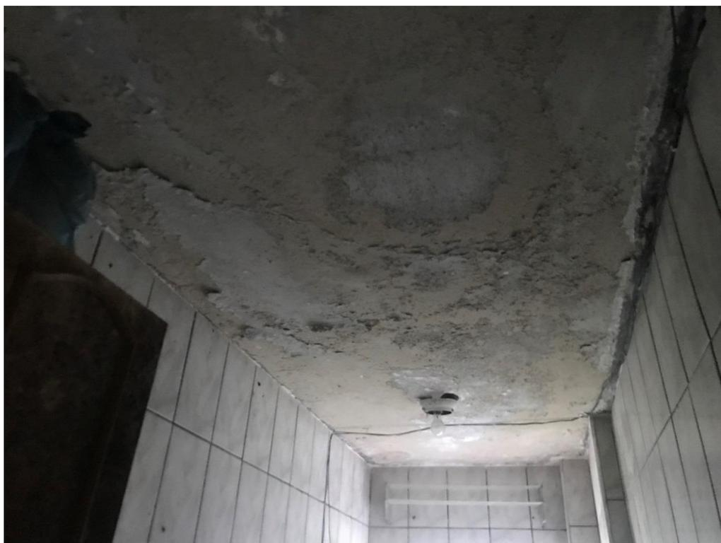
**Foto 23 - Teto da cozinha em péssimo estado devido a umidade do pavimento sobrejacente**
