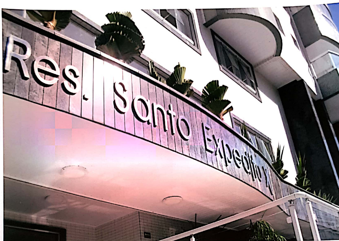
Foto nº 4 – detalhe da fachada do Condomínio
