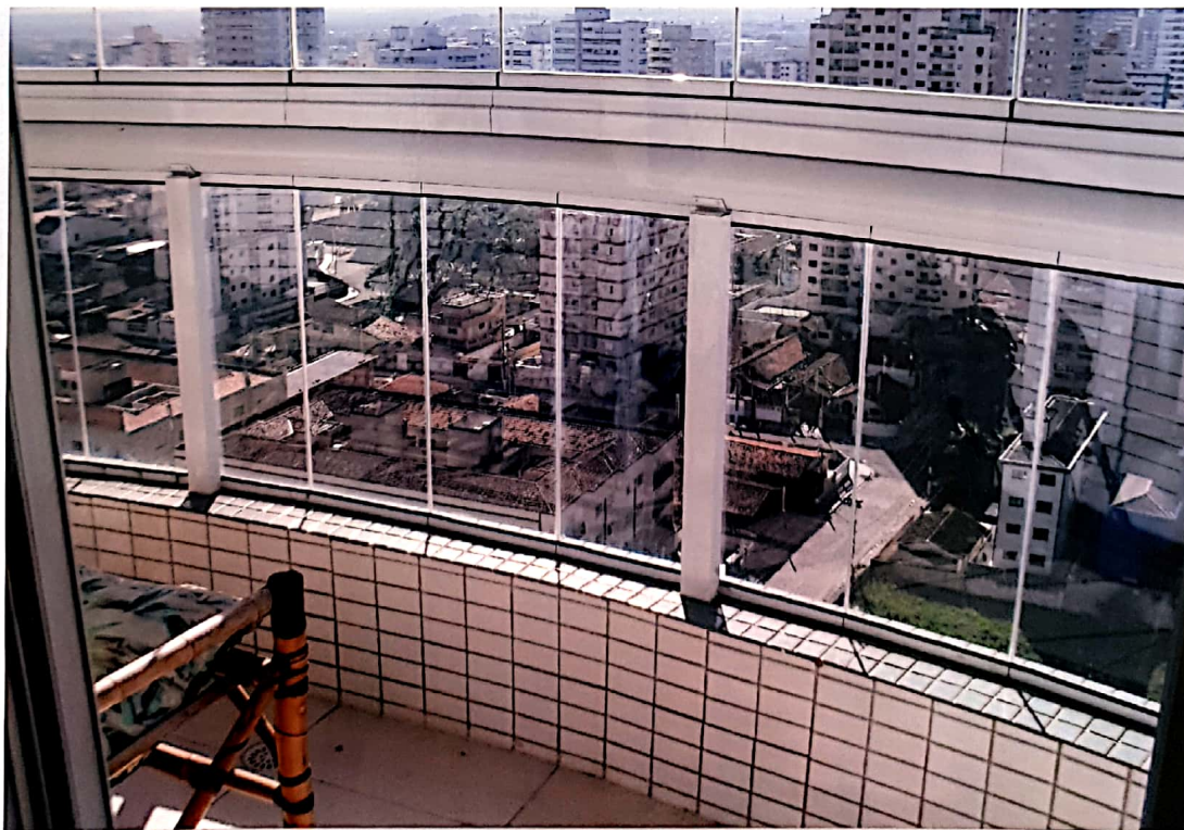
Foto nº 23 – sacada da suite master
