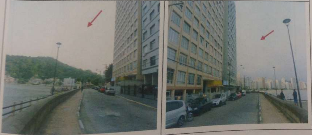
FOTO-SÉRIE 01 - ASPECTO GERAL DO LOCAL ONDE ESTÁ O EDIFÍCIO BIQUINHA, QUE CONTÉM A UNIDADE AVALIANDA, INDICADO POR SETA
