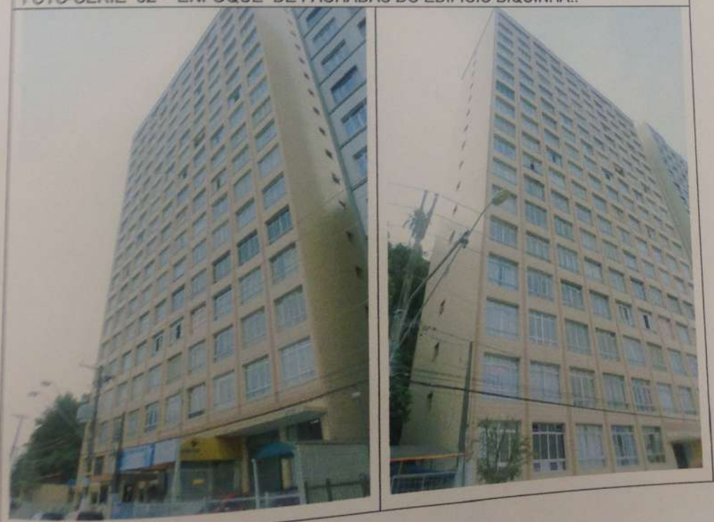
FOTO-SÉRIE 02 - ENFOQUE DE FACHADAS DO EDIFÍCIO BIQUINHA..
