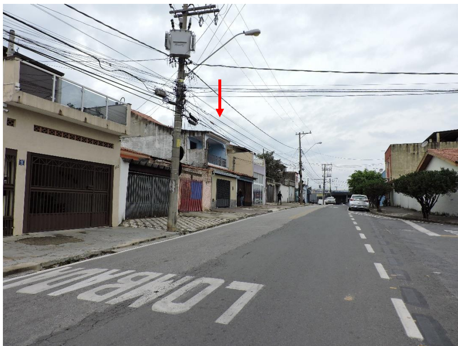
Vistas da Rua Gregório Ramos dos Santos (Destaca-se o imóvel avaliando)
