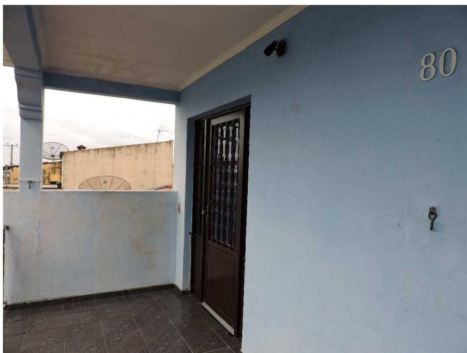
Vistas do imóvel avaliando (Edícula e Pavimento superior.)
