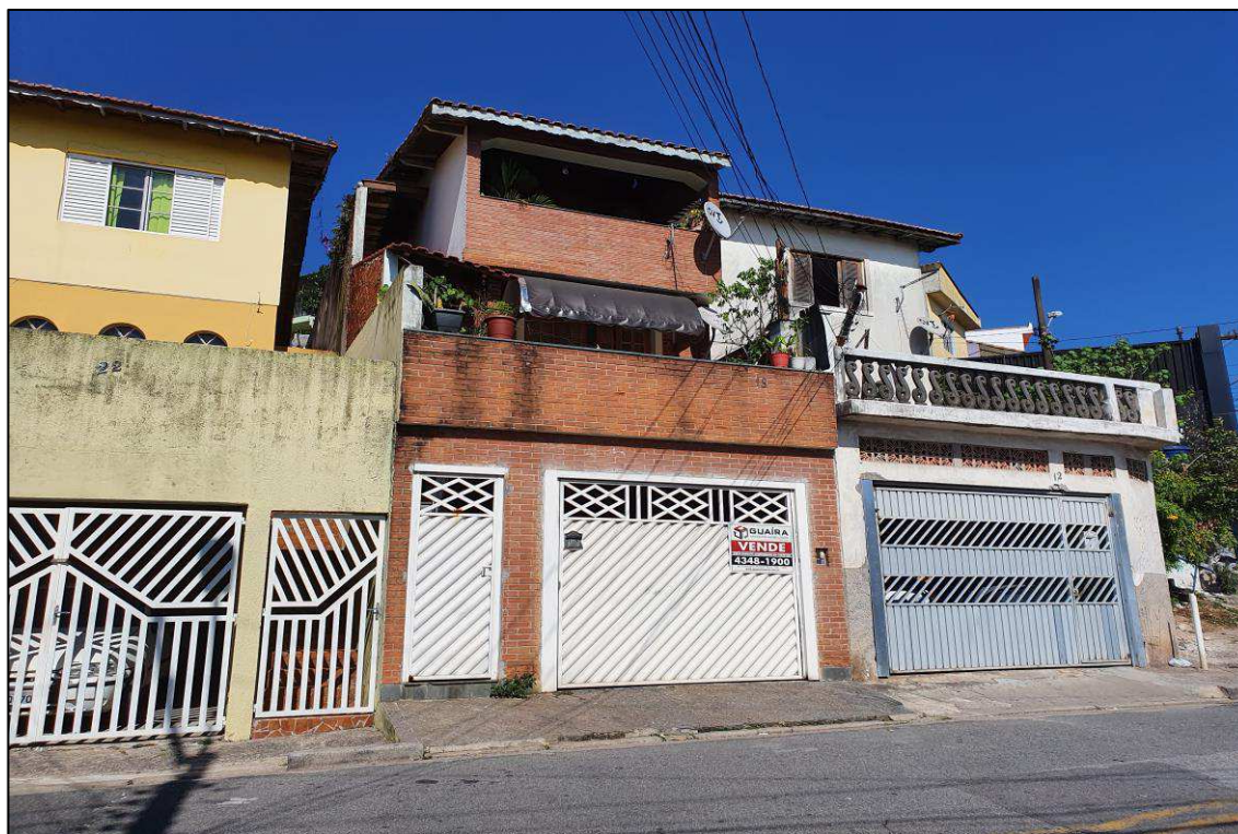
FOTO Nº 01 – Vista da fachada do imóvel avaliando.
