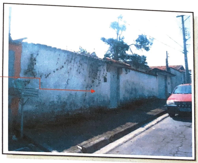
Vista de quem da Rua Araguaia olha para o imóvel avaliando;
