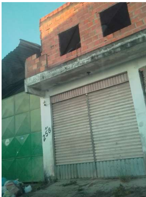
Imagem 2.26 – Fundos (Rua Suliman) do Estabelecimento Nº 2.660 da Av. Transnordestina (foto tirada in loco )
