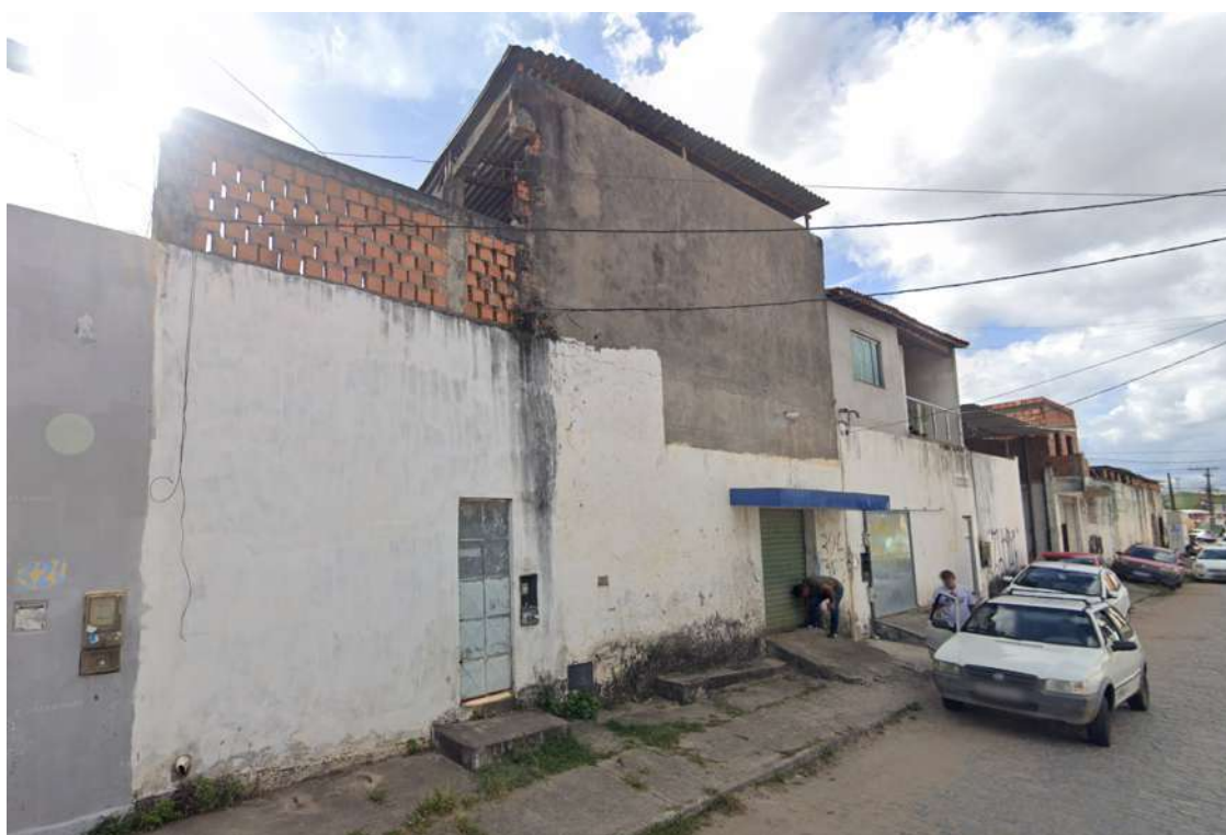
Imagem 2.21 – Fundos (Rua Suliman) do Estabelecimento Nº 2.630 da Av. Transnordestina
