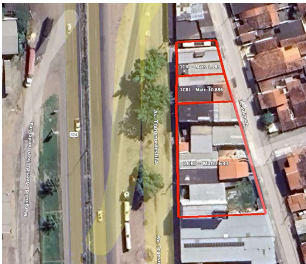
Imagem 2.02 – Foto aérea dos imóveis (reduzida)
