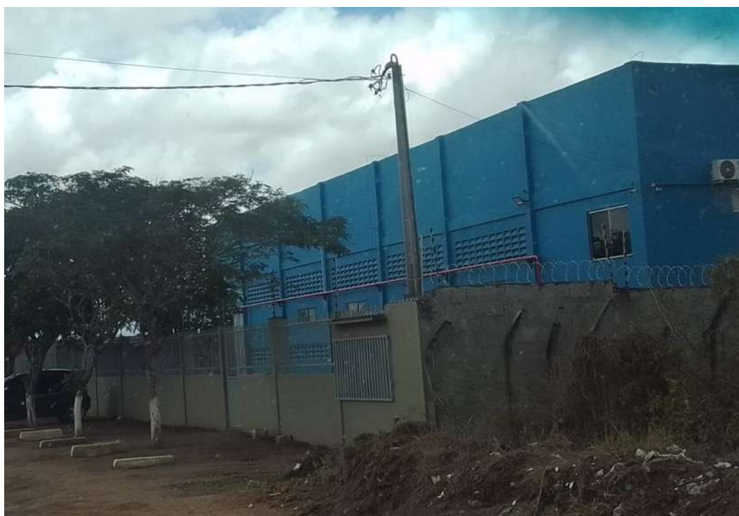
Imagem 3.13 – Vista da área de terra da Av. Banco do Nordeste, com divisa murada para galpão pintado de azul
