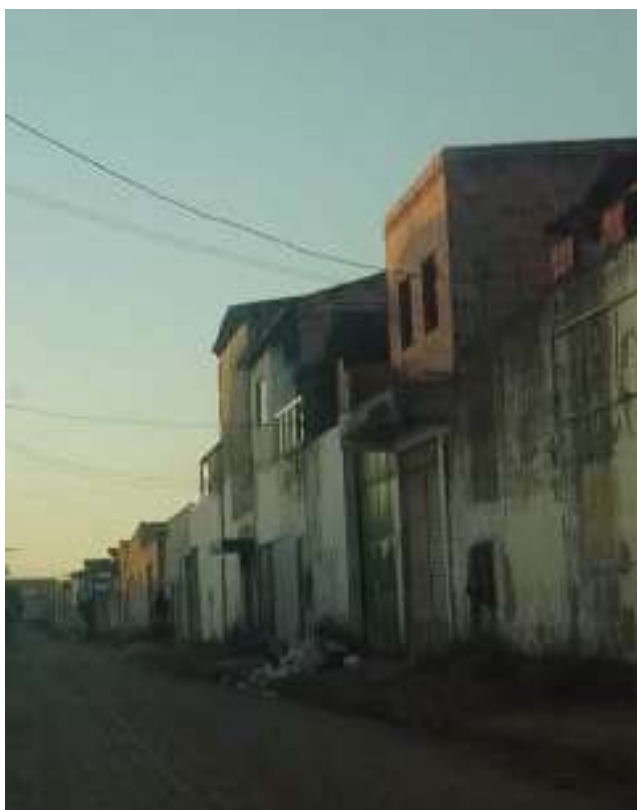
Imagem 2.25 – Fundos (Rua Suliman) do Estabelecimento Nº 2.668 da Av. Transnordestina (foto tirada in loco )
