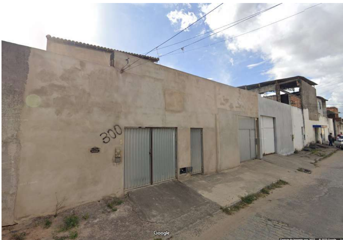
Imagem 2.20 – Fundos (Rua Suliman) do Estabelecimento Nº 2.604 da Av. Transnordestina
