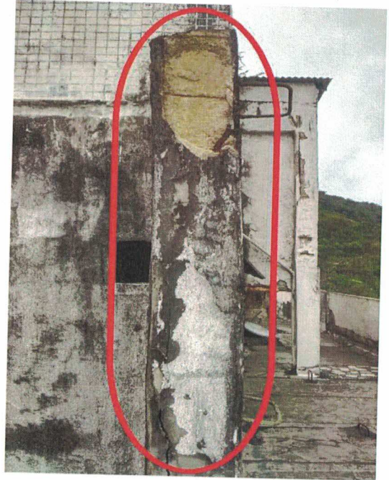
Pilar de sustentação (caixa d'água) - 02
