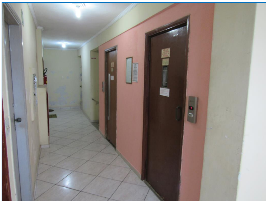
HALL DOS ELEVADORES NO 11º ANDAR.
