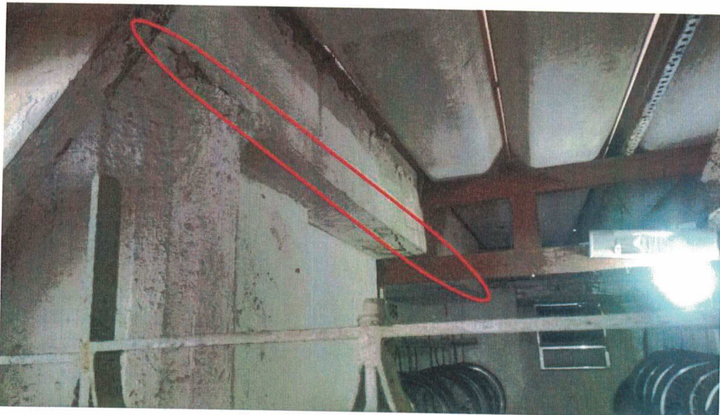
Estrutura externa (garagem)- 01
