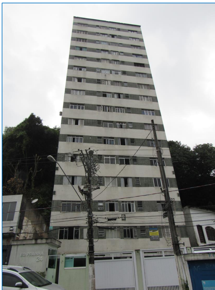
FACHADA DO EDIFÍCIO PRAINHA.
