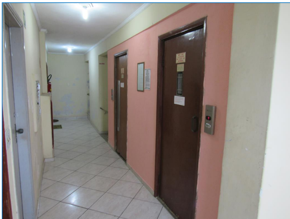
HALL DOS ELEVADORES NO 11º ANDAR.
