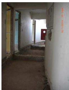
Corredor de acesso 11ª.
