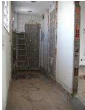
Corredor de acesso 11ª.
