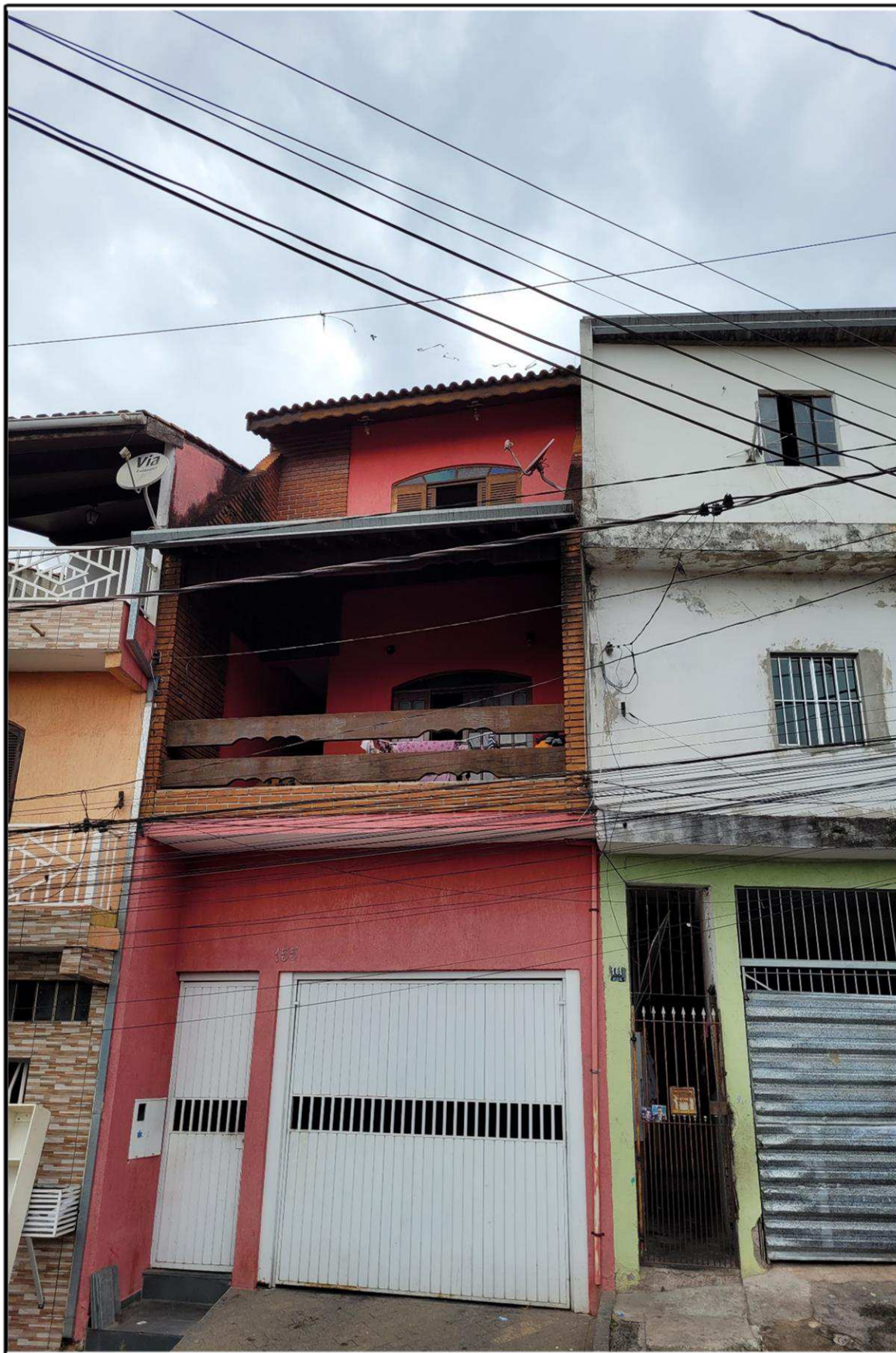
Foto 5 - Outra vista da fachada do imóvel.
