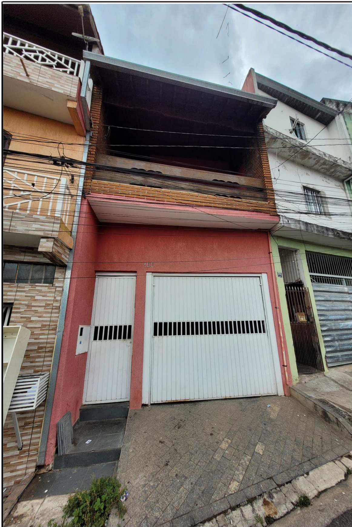
Foto 4 - Vista da fachada do imóvel.
