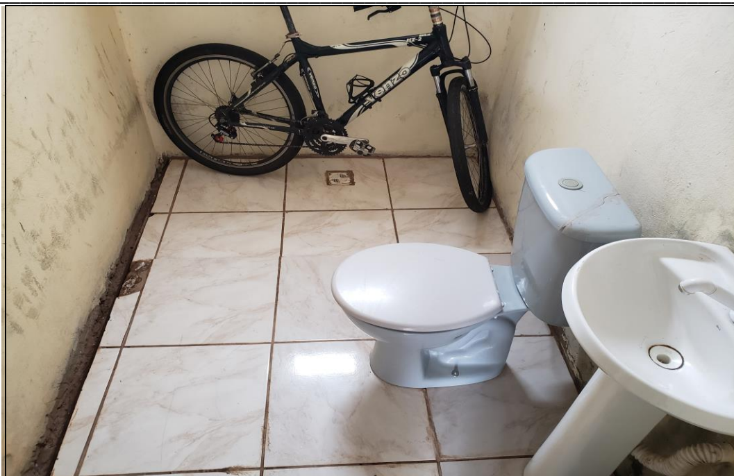
FOTO 05 – vista geral do lavabo na lanchonete.
