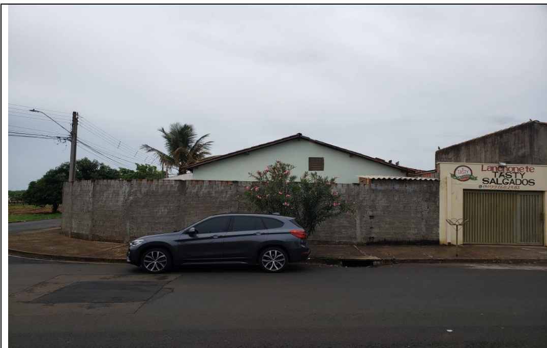
FOTO 02 – vista geral da lateral do imóvel. Avenida Jesuíno Ferreira Lopes.
