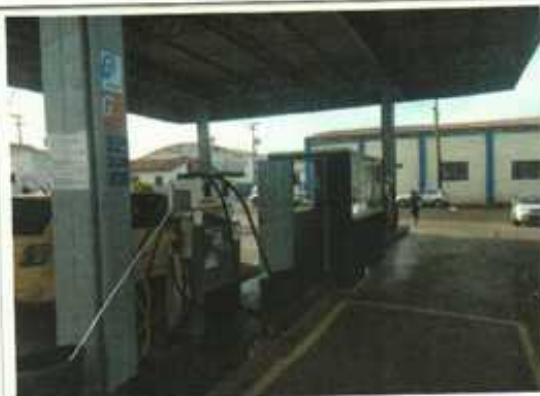
F 18 – ilha de Abastecimento – Alcool e Gasolina.
