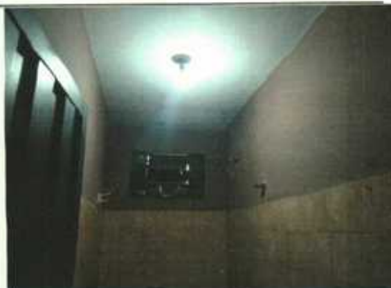
F 12 - Detalhe do revestimento das paredes até a altura de 1,50 m e laje.
