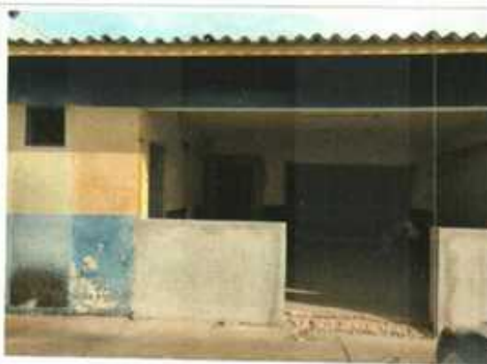
F 15 - Local do posto em obras.
