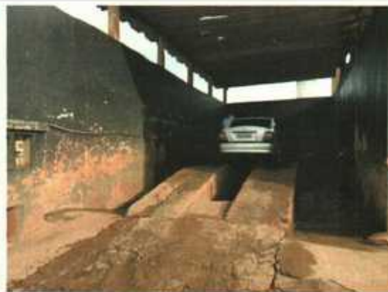
F 04 - Detalhe do Lavador do Imóvel.
