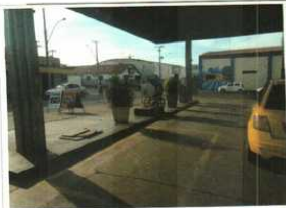
F 17 – ilha de Abastecimento – Diesel.
