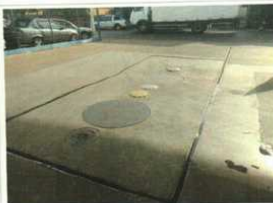
F 20 - Tanques de Abastecimento.
