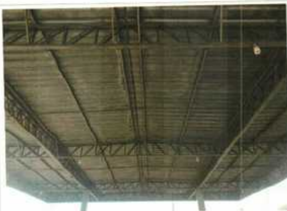
F 19 – Cobertura da Ilha de Abastecimento.
