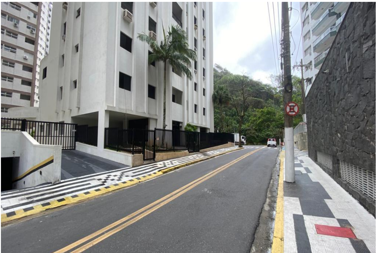
FOTO 02 – Vista parcial da Alameda Marechal Floriano Peixoto, onde se situa a fachada frontal do Edifício.
