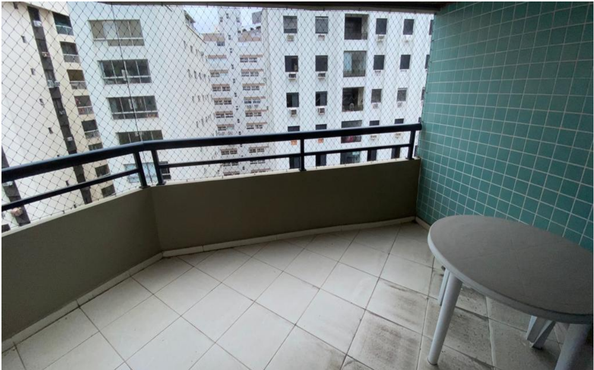
FOTO 05 – Vista Interna parcial interna do imóvel avaliando (Varanda).
