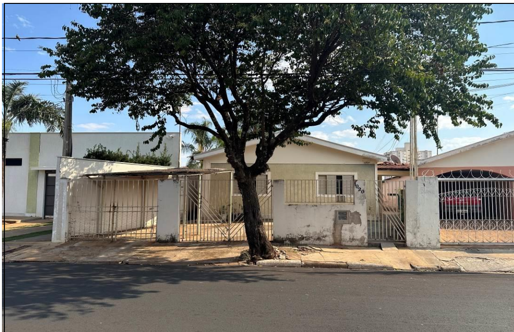
FOTO 01 – Vista geral frontal do imóvel avaliando.
