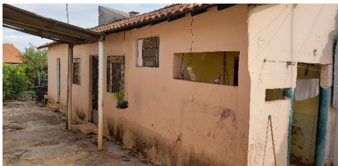
FACHADA DO BLOCO 03
