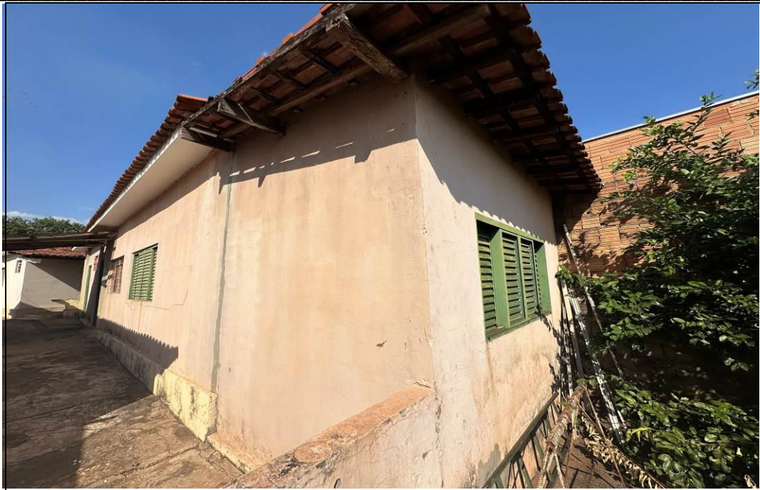
FOTO 11 – Vista parcial externa de uma das edificações nos fundos do imóvel (edícula I).
