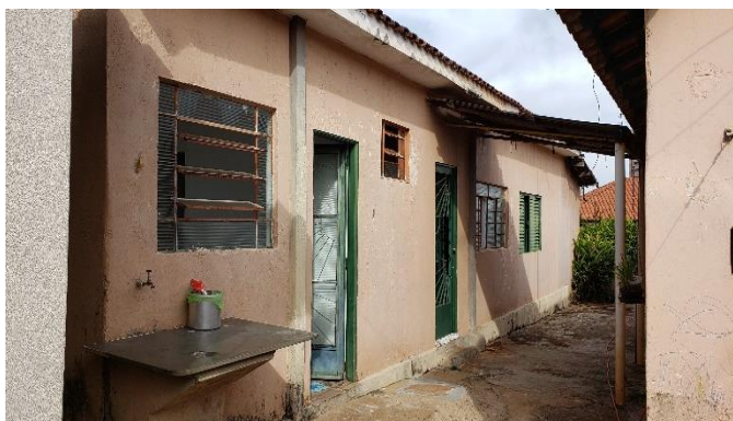
FACHADA DO BLOCO 02
