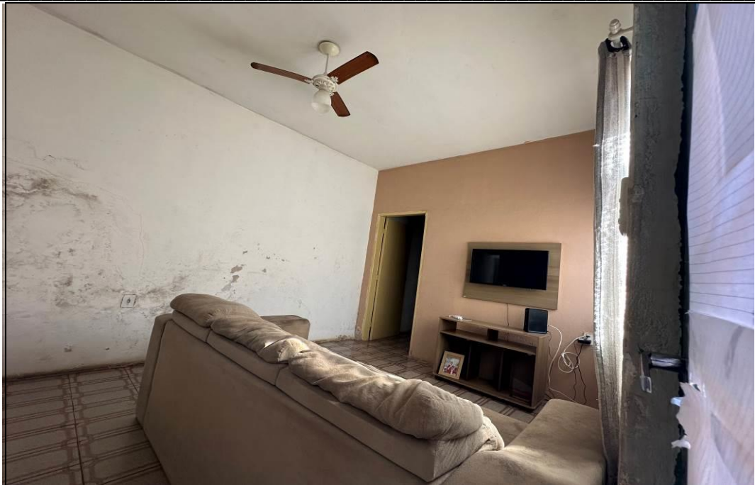
FOTO 13 – Vista parcial da sala do imóvel (edícula I).
