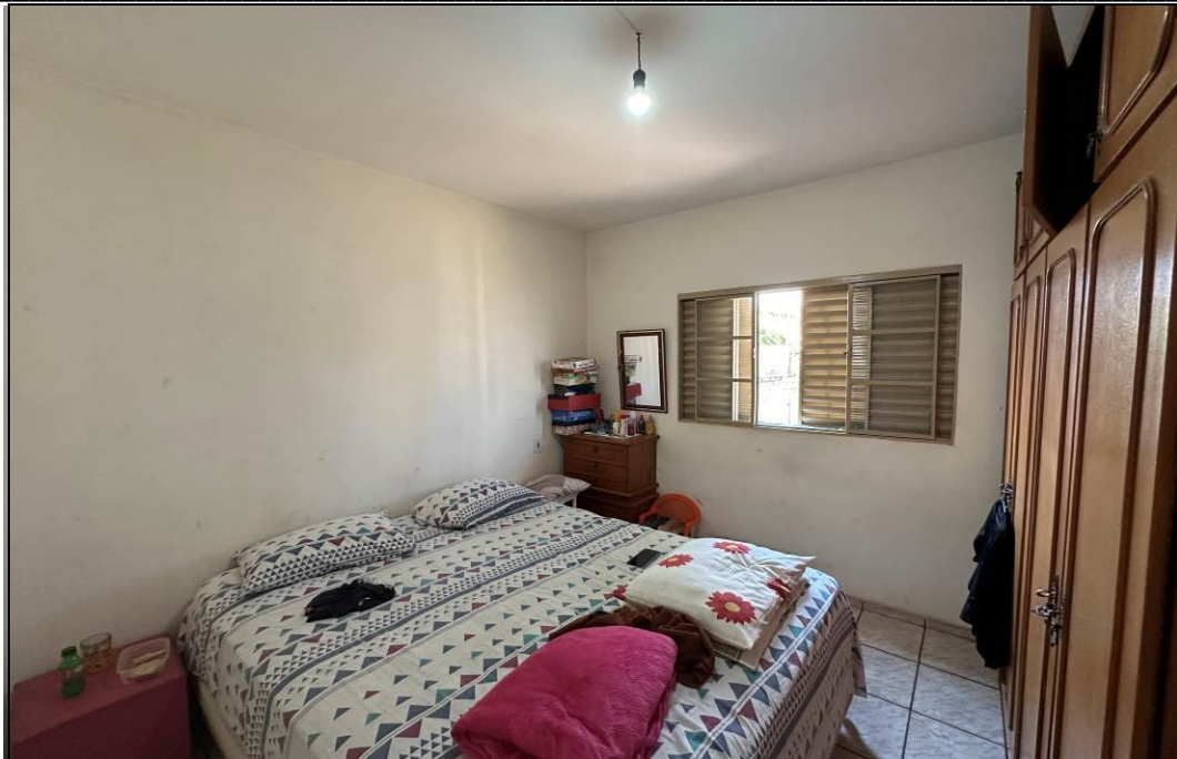
FOTO 07 – Vista parcial de um dos dormitórios.
