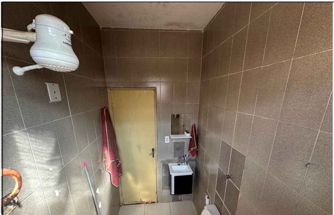
FOTO 12 – Vista parcial do banheiro do imóvel dos fundos (edícula I).
