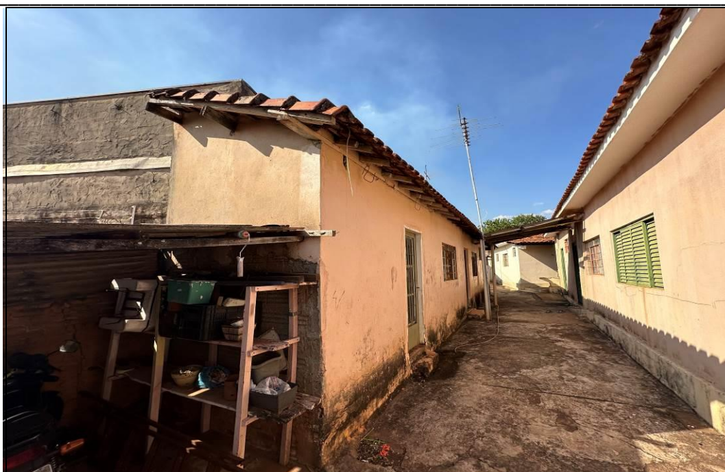
FOTO 15 – Vista parcial externa de uma das edificações nos fundos do imóvel (edícula II).
