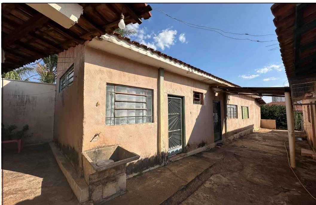
FOTO 10 – Vista geral externa de uma das edificações nos fundos do imóvel (edícula I).
