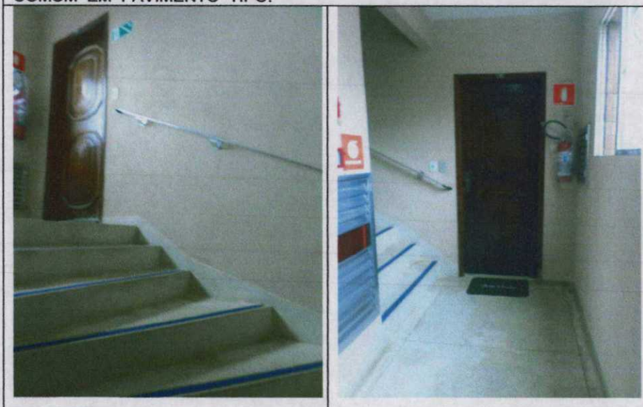
FOTO-SÉRIE 07 - DETALHES DA ESCADARIA E ÁREA DE CIRCULAÇÃO COMUM EM PAVIMENTO TIPO.
