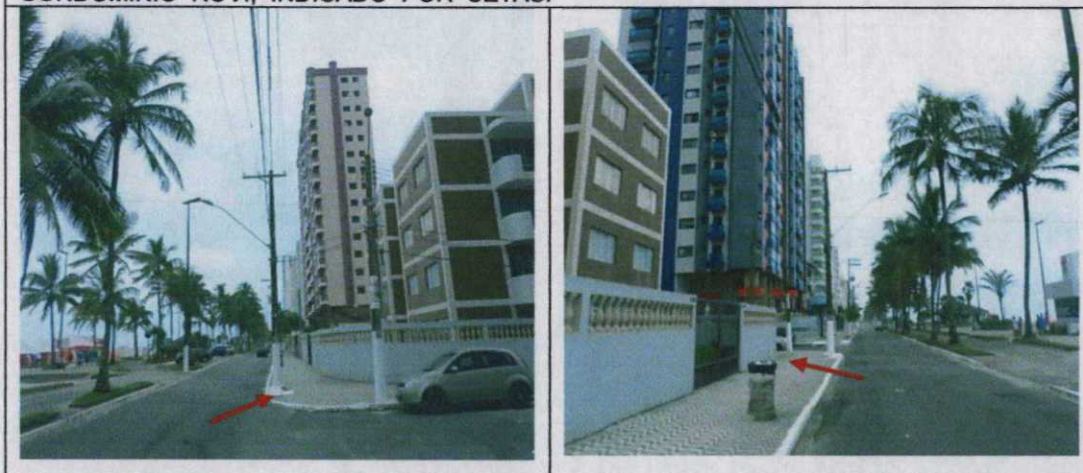
FOTO-SÉRIE 01 - ASPECTO GERAL DA ESQUINA DA AVENIDA PRESIDENTE CASTELO BRANCO (ORLA MARÍTIMA) COM A RUA FRANCISCO FIGUEROA, ESTÁ O CONDOMÍNIO ROVI, INDICADO POR SETAS.
