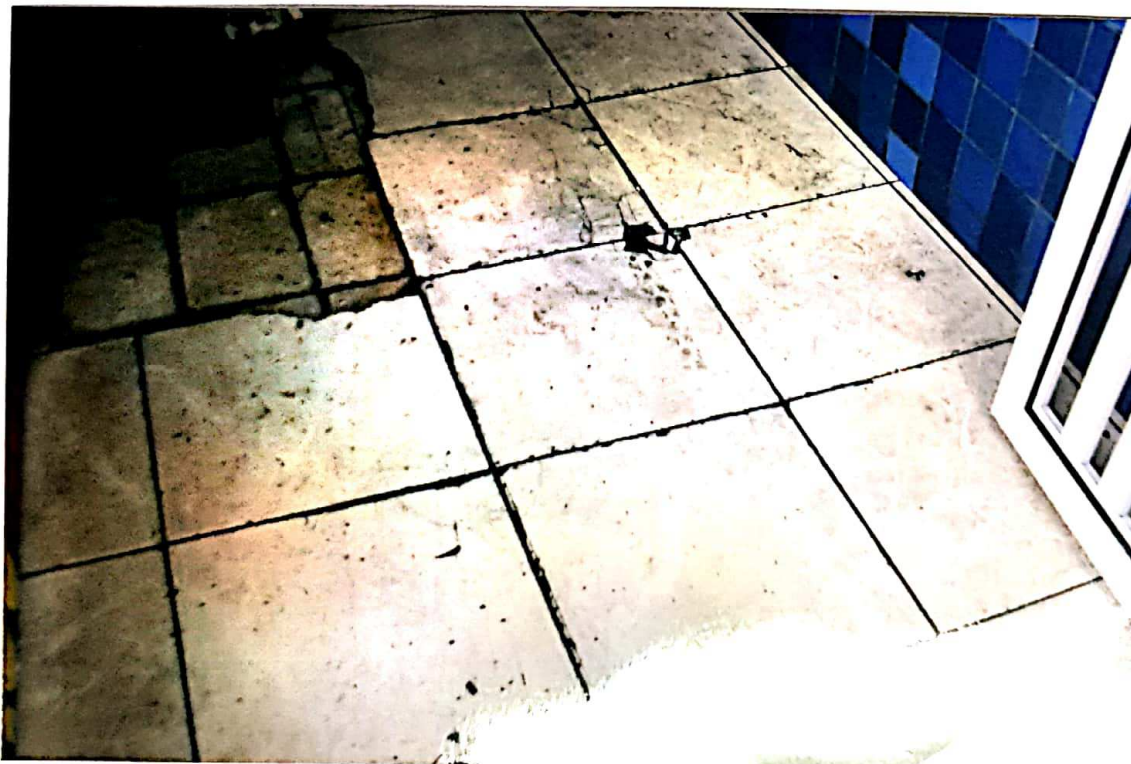
Foto nº 8 – Detalhe do piso cerâmico.
