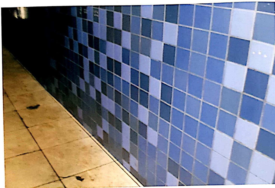
Foto nº 7 – Interior loja nº 02 – avaliando – com piso e paredes revestidos de cerâmica.
