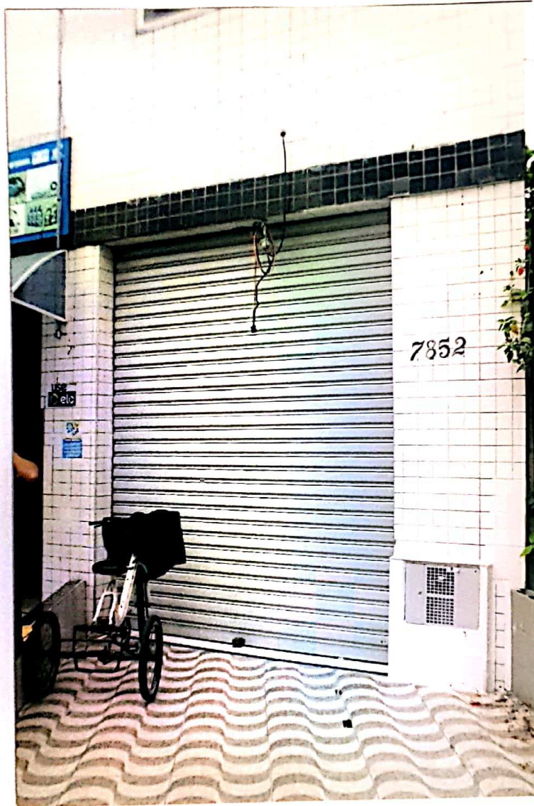
Foto nº 4 – Fachada loja nº 02 – avaliando – porta metálica de enrolar.
